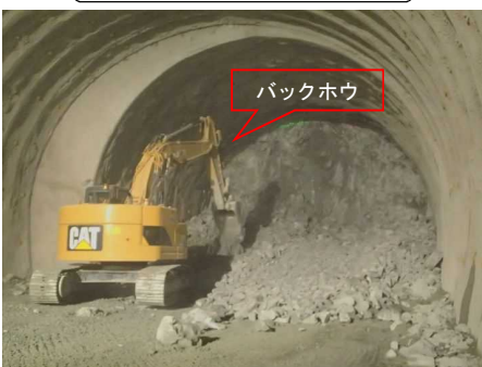
すり処理（すり積み）
