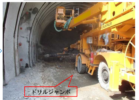
削孔（ロックボルト）
