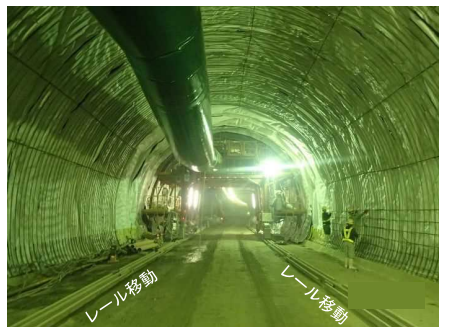
型枠移動（養生完了後）
