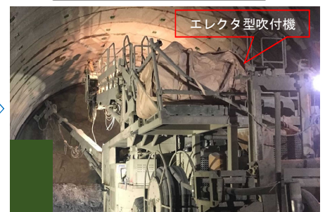
鋼アーチ支保工
