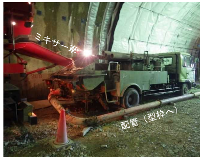
覆工コンクリート（打設）
