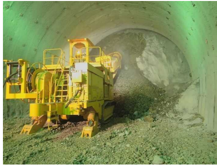
上半掘削（トンネル掘進機）
