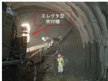
吹付コンクリート
