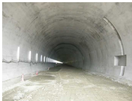
覆工コンクリート打設完了
