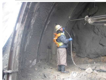
モルタル充填（ロックボルト）
