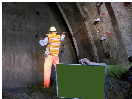
打設（ロックボルト）
