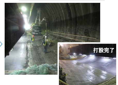
インバートコンクリート打設
