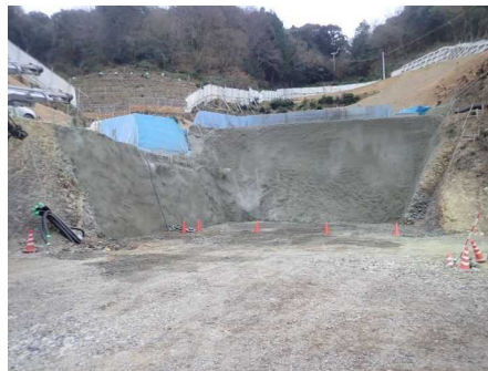
吹付コンクリート施工
