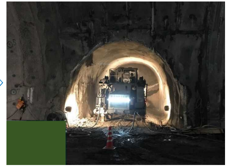
削孔（ロックボルト）
