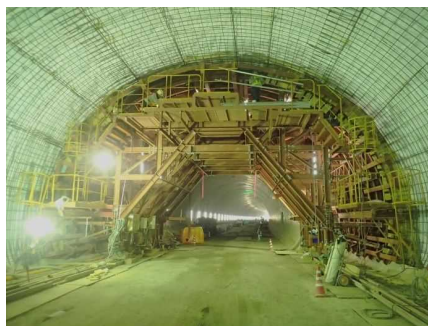
型わく据付完了
