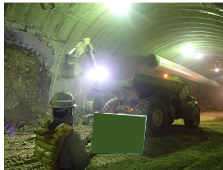
ずり処理（ずり積み）
