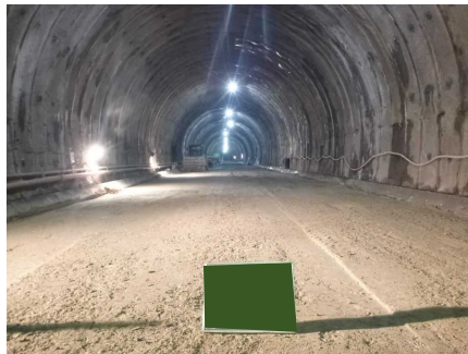
インバート締め完了
