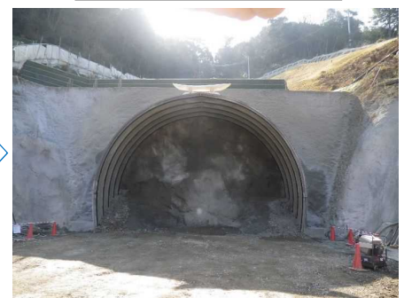
坑口切付け施工完了
