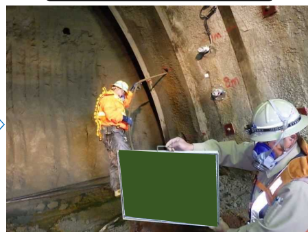
モルタル充填（ロックボルト）
