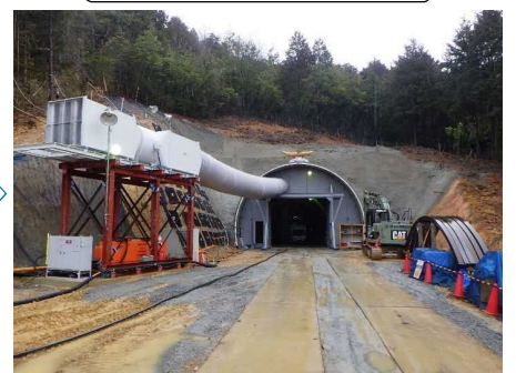
換気設備工（設置完了）
