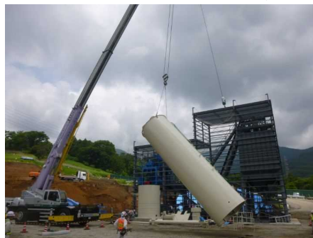
吹付設備工（搬入設置状況）
