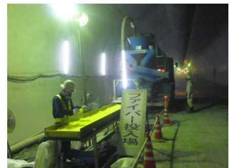
繊維現地混合（覆工コンクリート）
