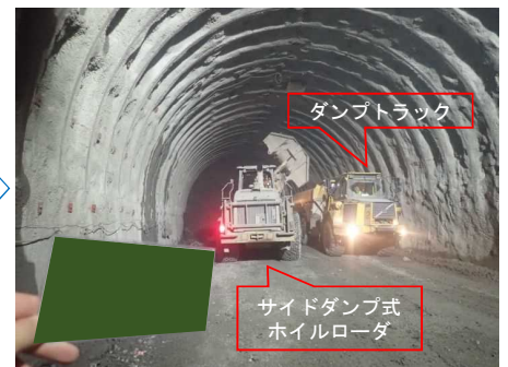
すり処理（すり積み・運搬）
