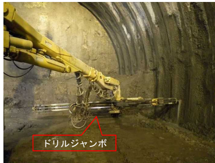
削孔（ロックボルト）
