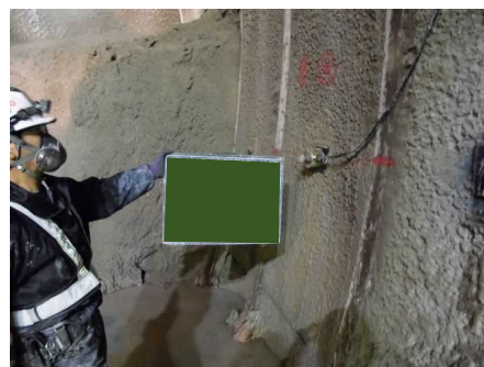
計測工B（ロックボルト軸力試験）
