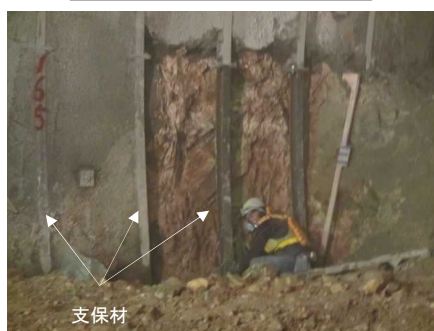
鋼アーチ支保工
