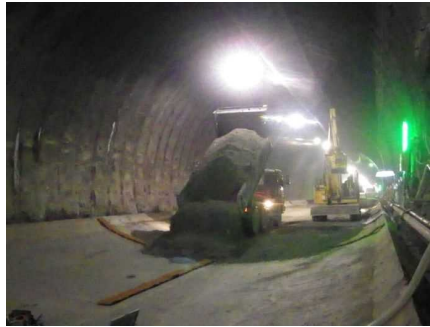
インバート締め完了
