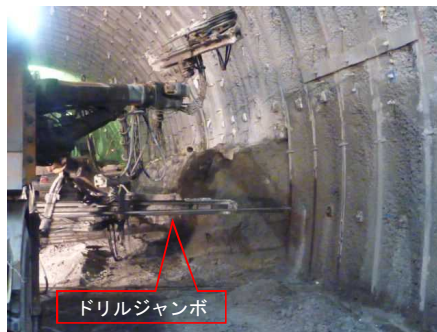
ロックボルト打設
