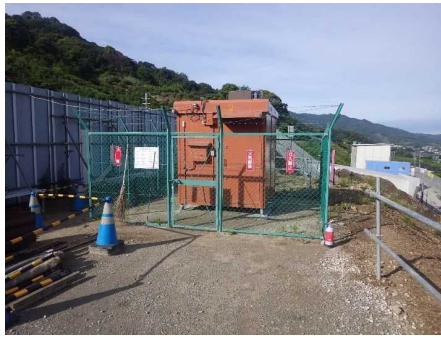
汚濁水処理工（設置状況）
