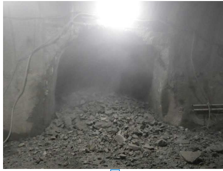
ずり処理（ずり積み）
