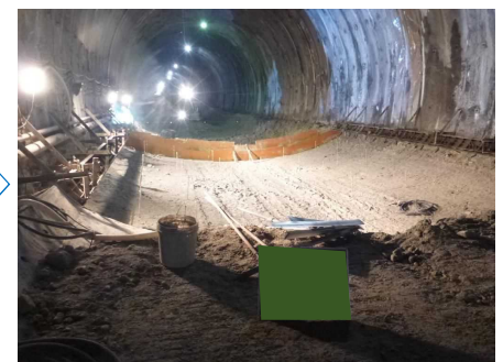
インバート型枠
