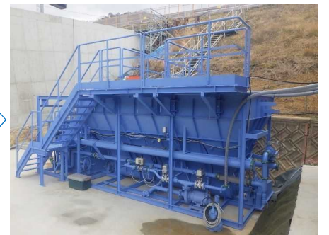
汚濁水処理工（設置完了）
