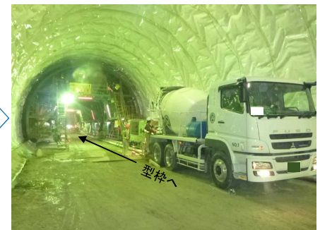
覆工コンクリート（ミキサー車）
