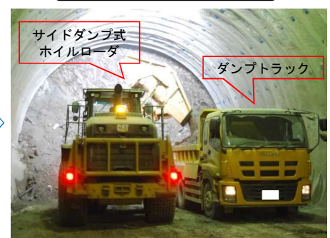
すり処理（すり積み込み）
