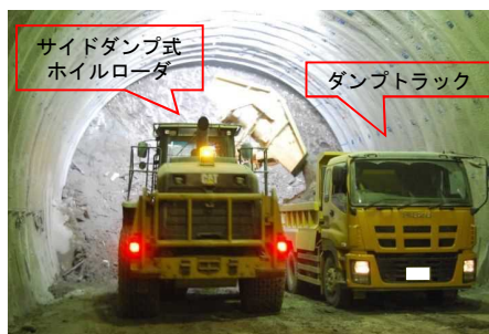
ずり処理（ずり積み）
