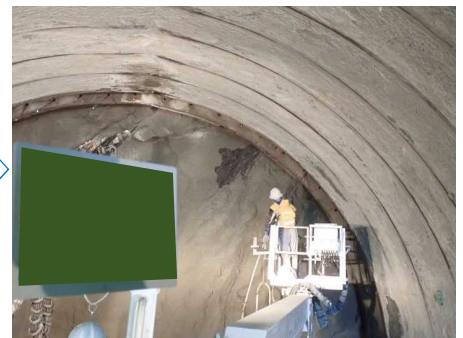
モルタル充填（フォアポーリング）
