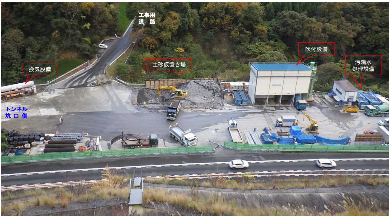
施工ヤード全景
