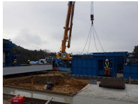
汚濁水処理工（設置状況）
