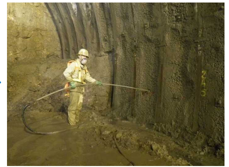
モルタル充填（ロックボルト）
