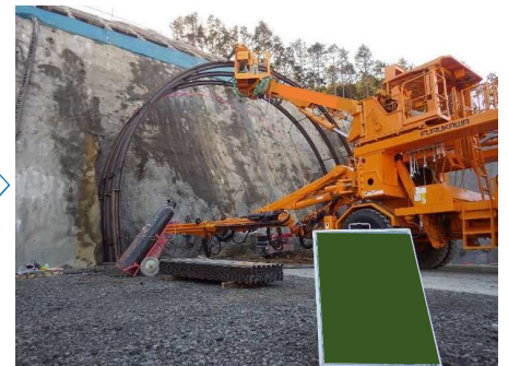
鋼アーチ支保工設置
