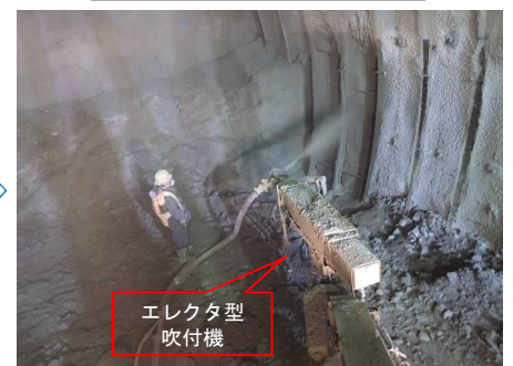
吹付コンクリート
