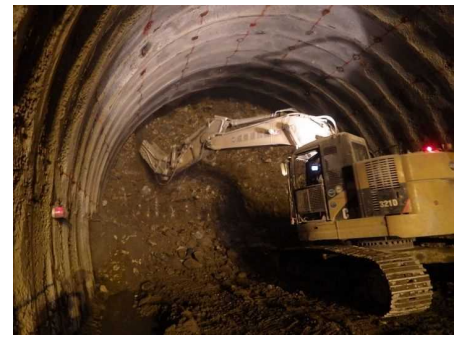
上半掘削（油圧切削機）
