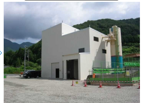
吹付設備工（設置完了）
