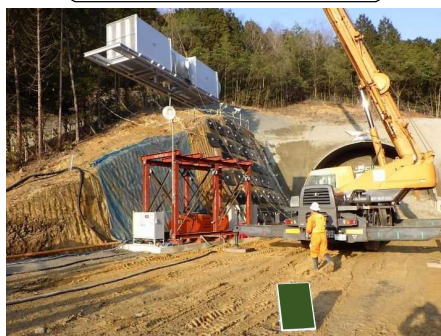
換気設備工（設置状況）
