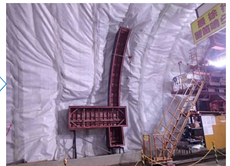
型わく据付(箱抜き型わく)
