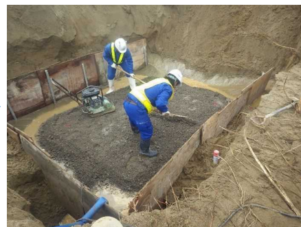
基礎材敷均し・締固め
