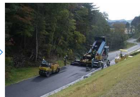
簡易舗装工（締固め）
