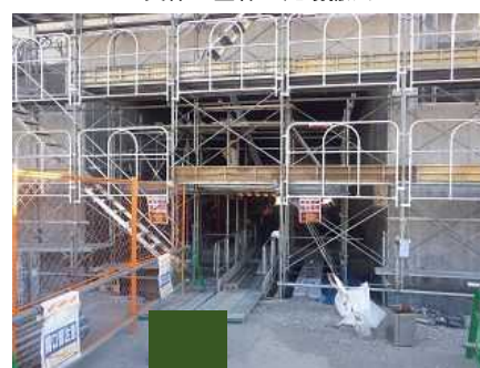
支保・型枠・足場撤去
