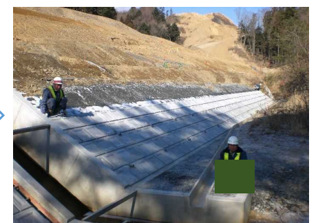
コンクリートブロック張り
