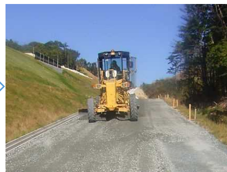
簡易舗装路盤工
