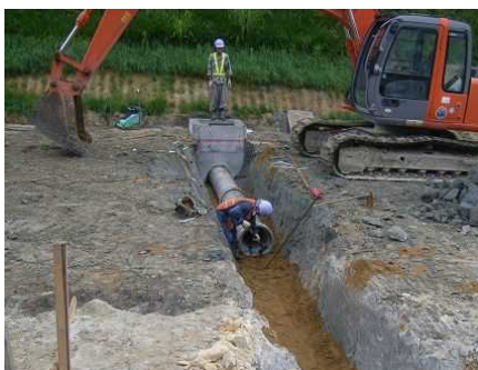
用排水管設置
