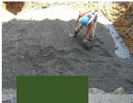
基礎材敷均し・締固め
