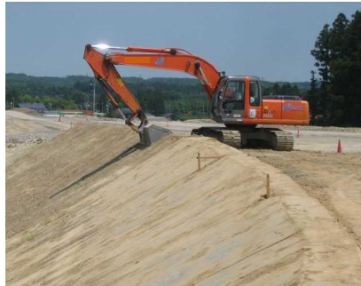
盛土のり面仕上げ（削取り）
