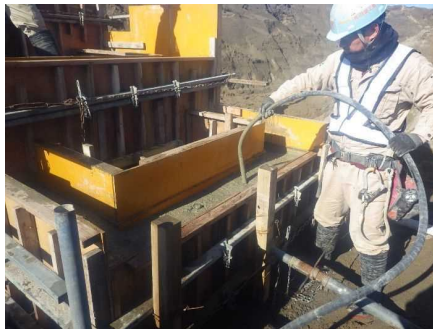
コンクリート打設
