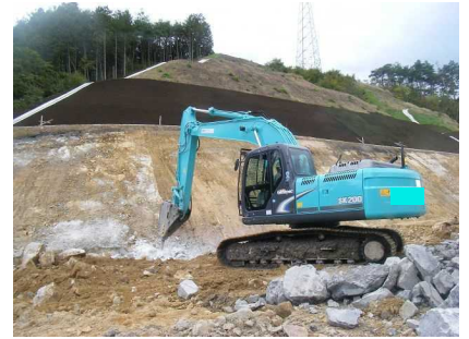
切土のり面仕上げ（硬岩）
