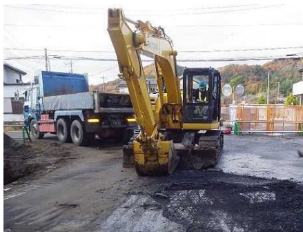
舗装版取壊し
