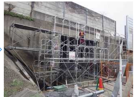
足場・支保設置
