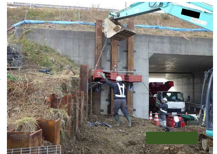
鋼製山留材設置
