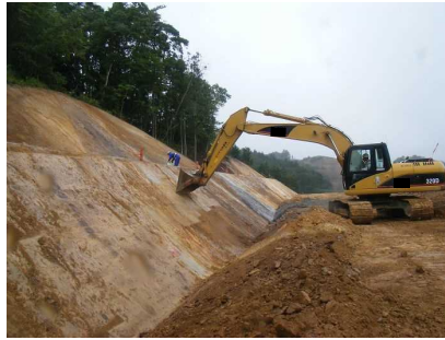
切土のり面仕上げ（土砂）
