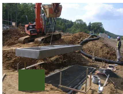
油水分離ます設置
