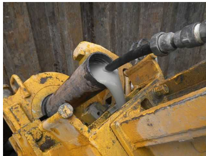
グラウト注入
