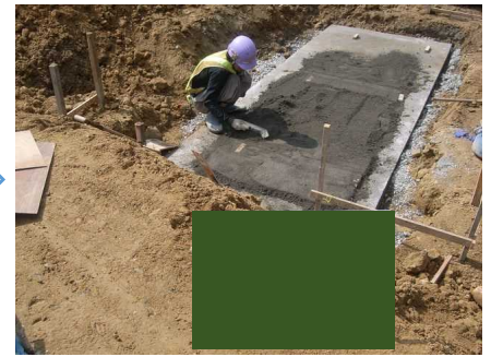
敷モルタル設置
