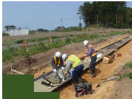
パイプ組立（ボトムセクション）
