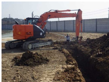
掘削・整正（床付）
