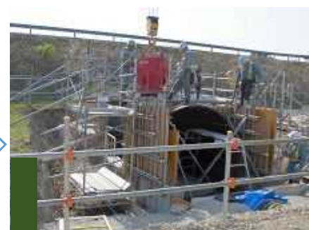
コンクリート打設②
