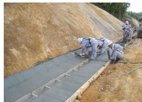
コンクリート打設
