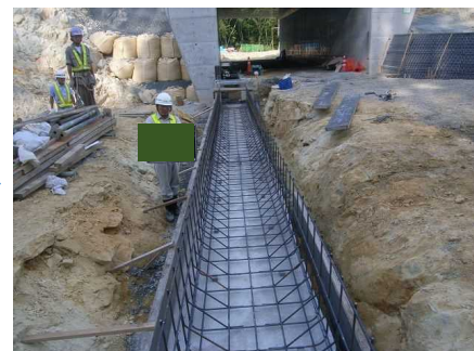
鉄筋加工・組立て
