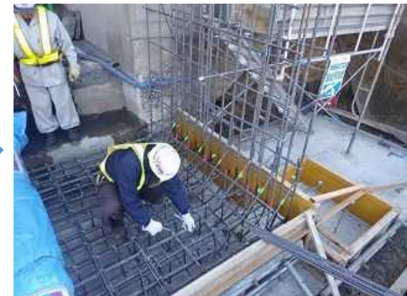
底板鉄筋加工・組立て
