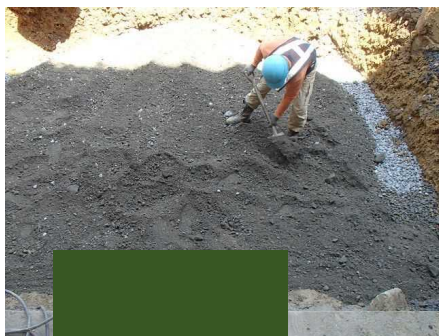
基礎材敷均し・締固め
