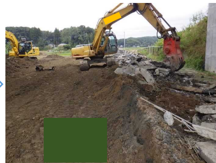
取壊し（圧碎機）
