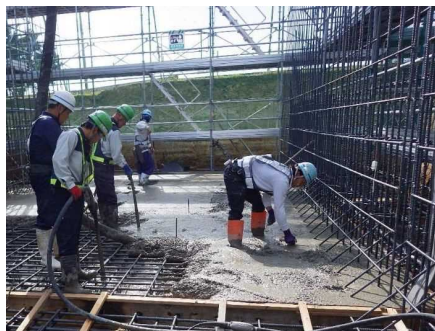
底版コンクリート打設
