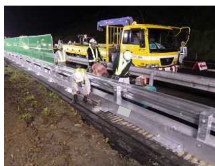
固定用アンカーピン打込み
