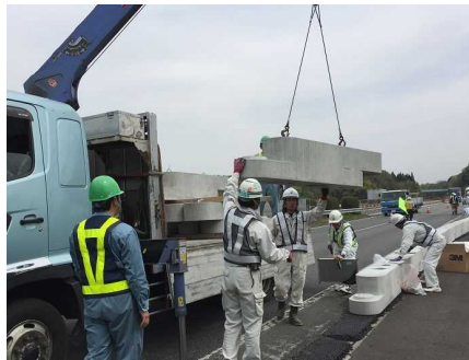
連続基礎ブロック設置
