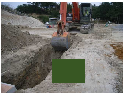
掘削・整正 (床付)
