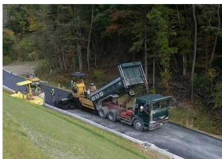
簡易舗装工（敷均し）
