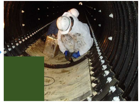
パイプ組立（目地仕上げ）
