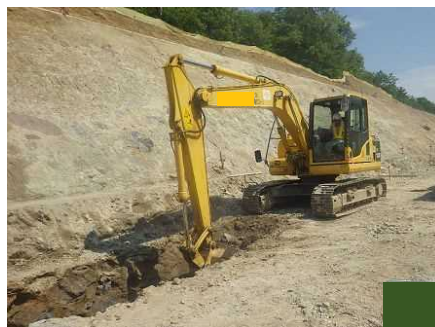
掘削・整正（床付）
