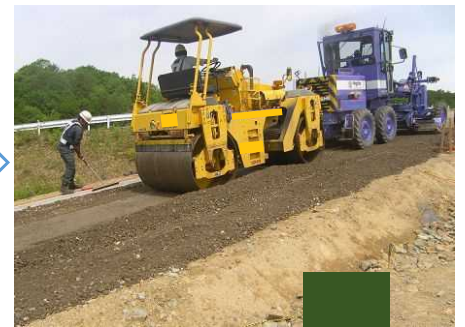
簡易舗装路盤工 (転圧)
