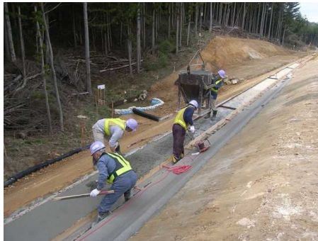
コンクリート打設
