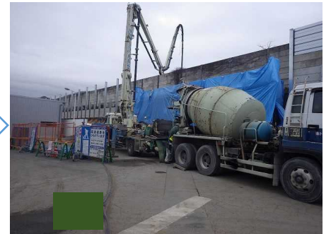
コンクリート打設・養生
