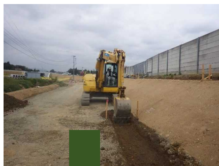
掘削・整正（床付）
