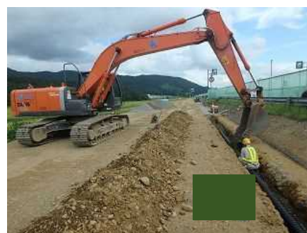
フィルター材設置
