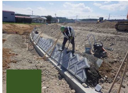
胴込め（コンクリート）
