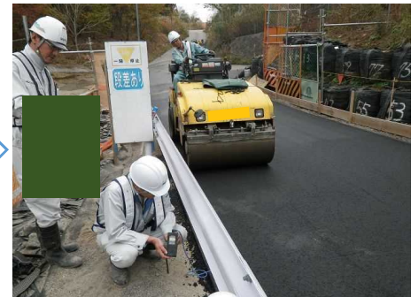
簡易舗装工 (締固め)
