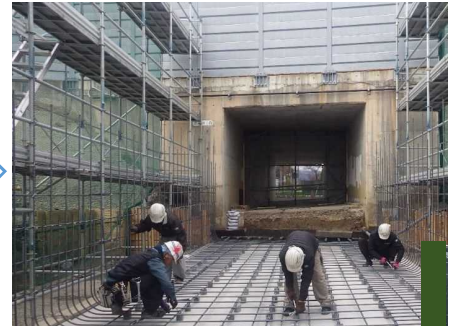
底版鉄筋加工・組立て
