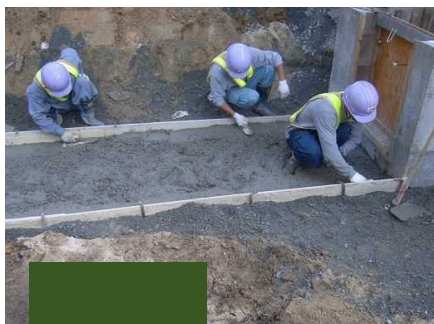
均しコンクリート打設
