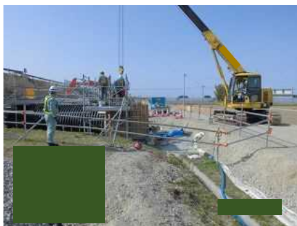
コンクリート打設①
