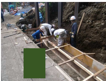
型枠製作・組立て
