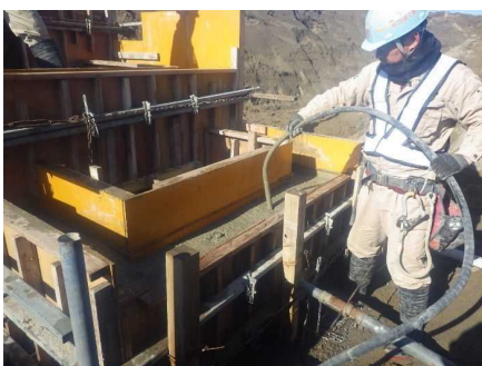
コンクリート打設
