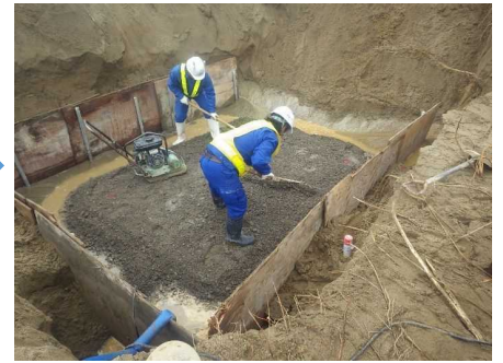
基礎材敷均し・締固め
