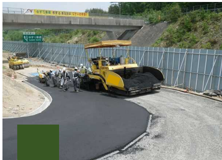
簡易舗装工 (敷均し)
