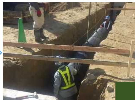
用排水管設置
