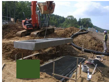
油水分離ます設置
