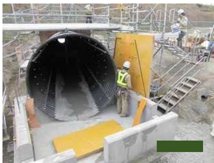
型枠組立①
