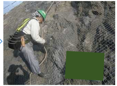
アンカーピン設置
