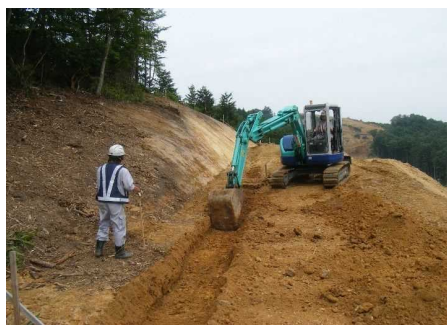
掘削・整正（床付）
