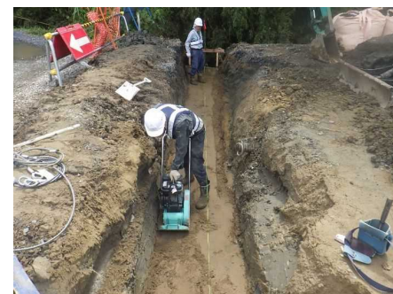
基礎材敷均し・締固め
