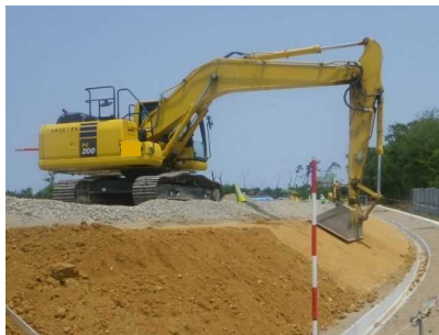
盛土のり面仕上げ（削取り）
