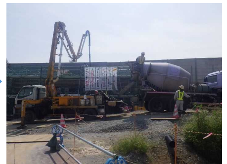
コンクリート打設・養生
