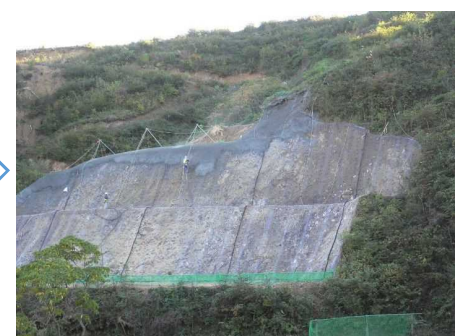
モルタル吹付
