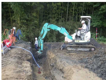
掘削・整正（床付）
