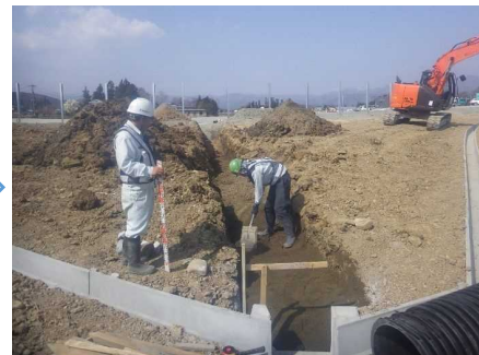
基礎材敷均し・締固め
