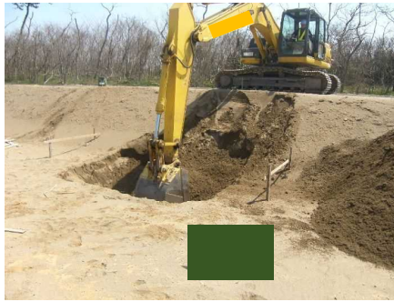
掘削・整正（床付）
