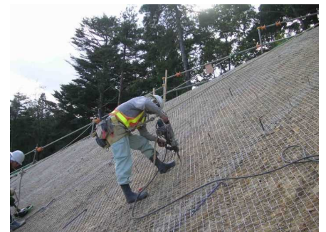
アンカーピン設置
