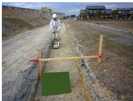
掘削・整正（床付）
