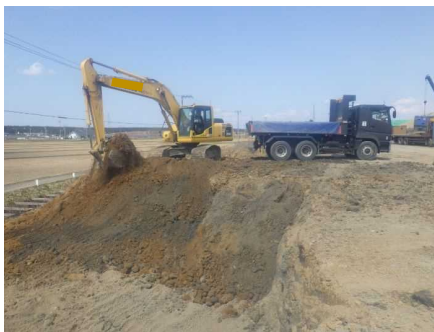
掘削・積み込み
