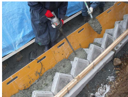
胴込め（※コンクリート打設の場合）
