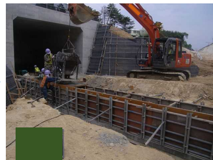
コンクリート打設
