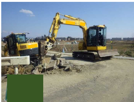
取壊し（大型ブレーカ）
