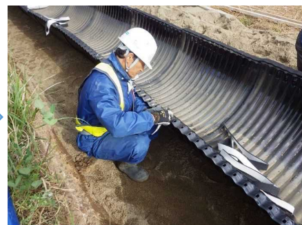
パイプ組立（ボトムセクション）
