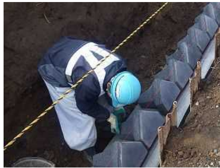
コンクリートブロック積み①
