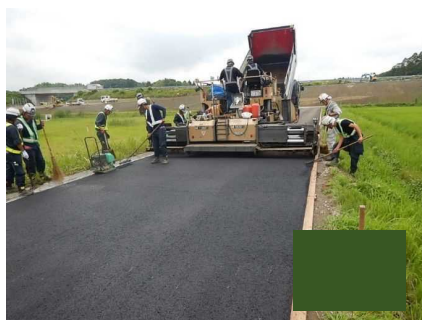
簡易舗装工（敷均し）
