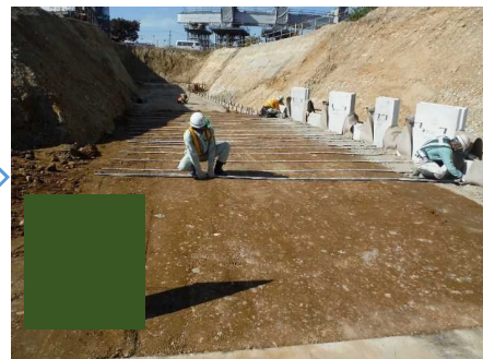
補強材設置
