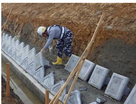
コンクリートブロック積み①
