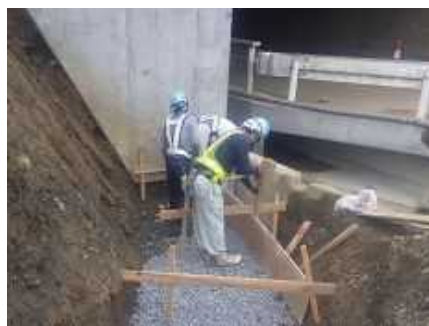
型枠製作・組立て
