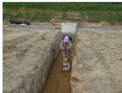
基礎材敷均し・締固め
