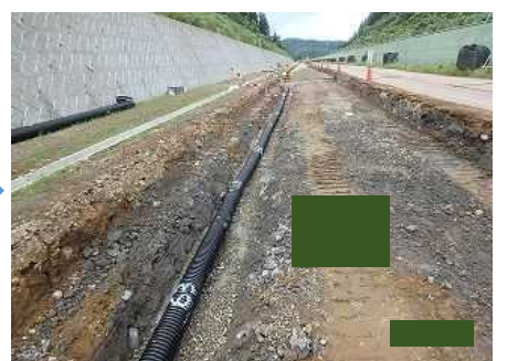
地下排水管設置
