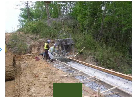
天端コンクリート打設
