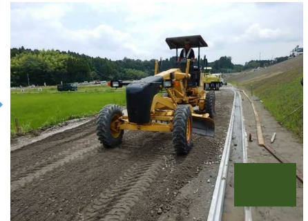
簡易舗装路盤工
