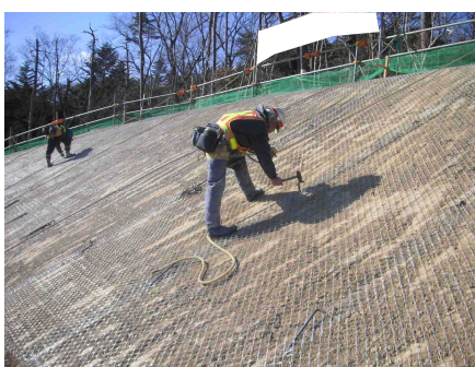
アンカーピン設置
