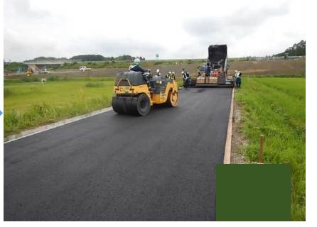
簡易舗装工（締固め）
