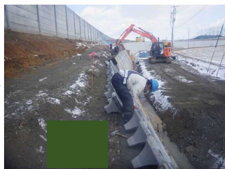
コンクリートブロック積み②
