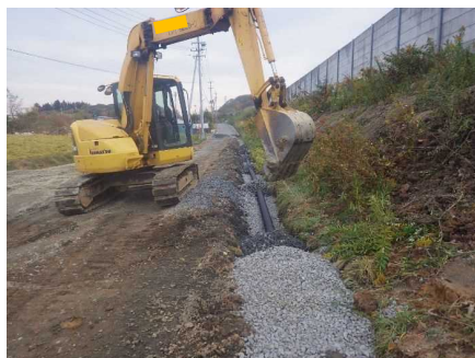
フィルター材設置
