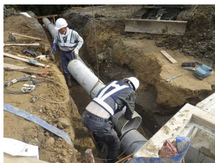
用排水管設置
