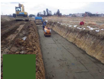
基礎材敷均し・締固め
