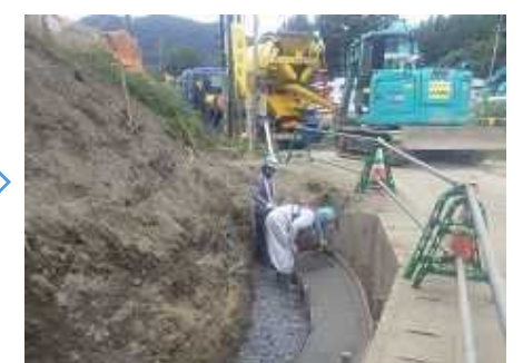
コンクリート打設
