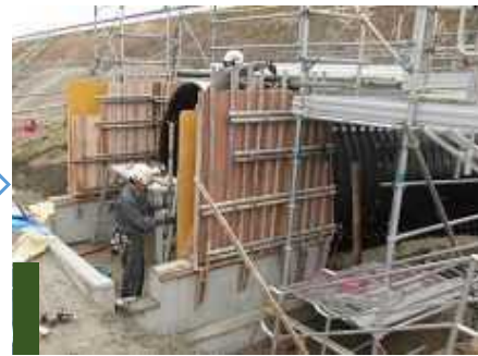
型枠組立②
