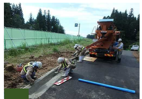
コンクリート打設
