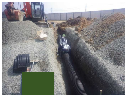
用排水管設置
