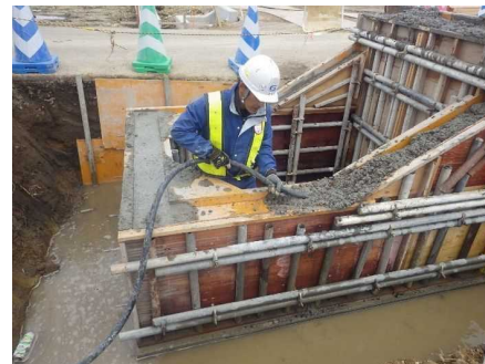
コンクリート打設
