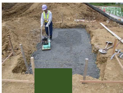
基礎材敷均し・締固め
