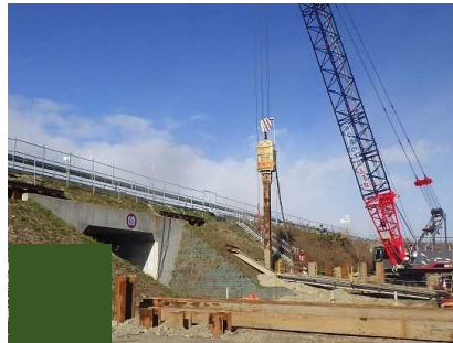
打込み（H型鋼）
