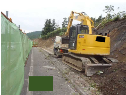
掘削・積込み
