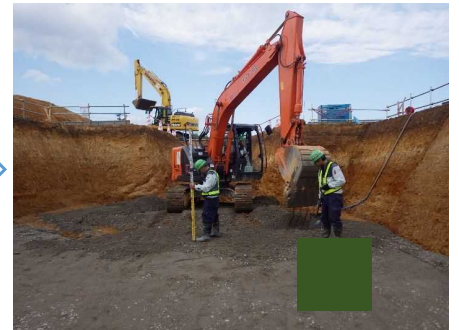
基礎材敷均し
