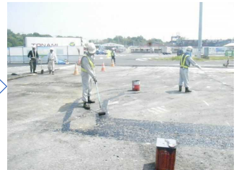
瀝青材散布工
