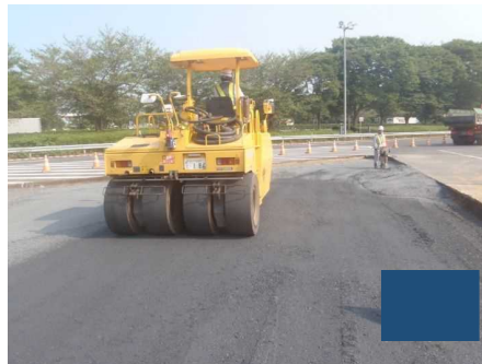
締固め(2次転圧)
