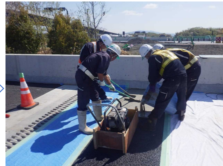
セメントミルク注入
