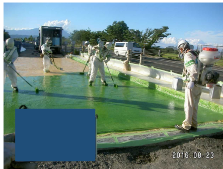
舗装接着材塗布
