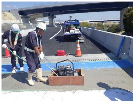
セメントミルク振動・締固め
