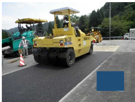
試験舗装(2次転圧)
