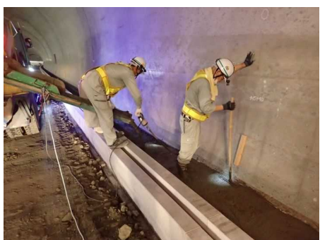
均しコンクリート打設
