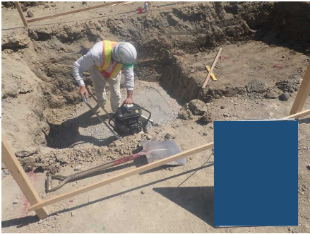
基礎材締固め
