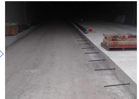
1車線分打設完了
