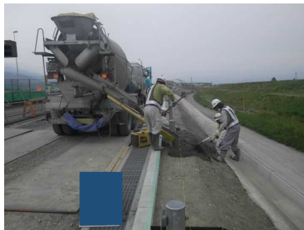
コンクリート打設
