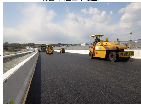
締固め(仕上げ転圧)
