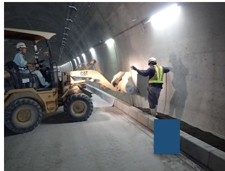
中詰土充填・締固め
