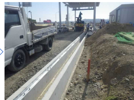
用排水溝完成
