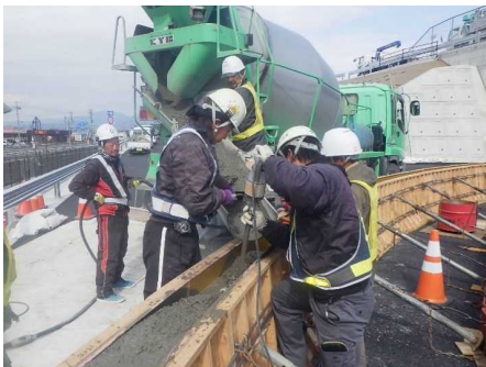
コンクリート打設
