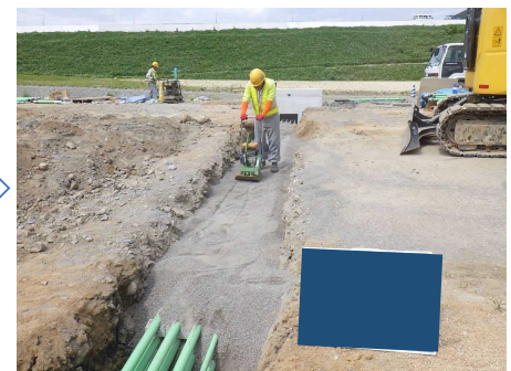
保護砂埋戻し・締固め
