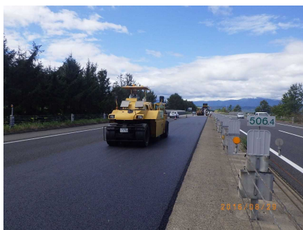
締固め（2次転圧）
