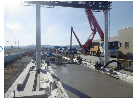
コンクリート打設
