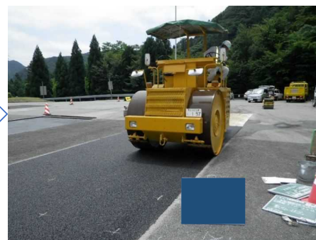
試験舗装(1次転圧)
