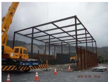
骨材仕切、上屋設置
