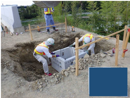
ハンドホール据付
