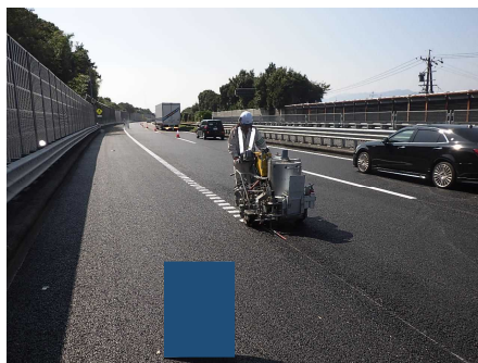
リブのみ施工
