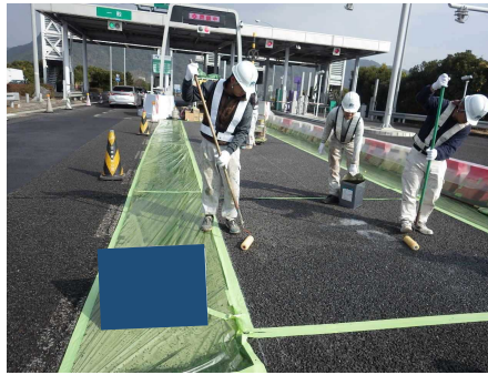
プライマー塗布
