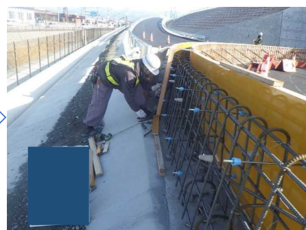
鉄筋工・型枠工
