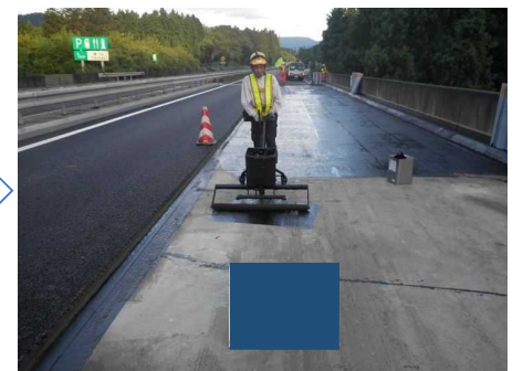
プライマー塗布
