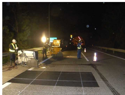
既設舗装の切断
