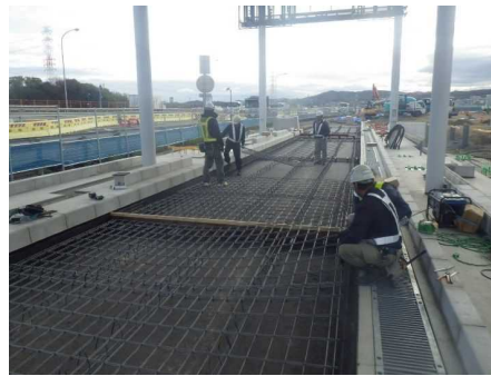
鉄網・補強鉄筋配置
