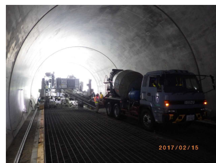
コンクリート打設
