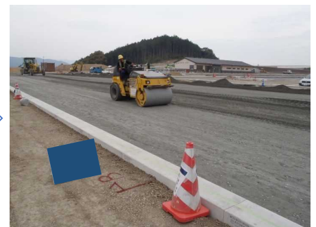
締固め(2次転圧)
