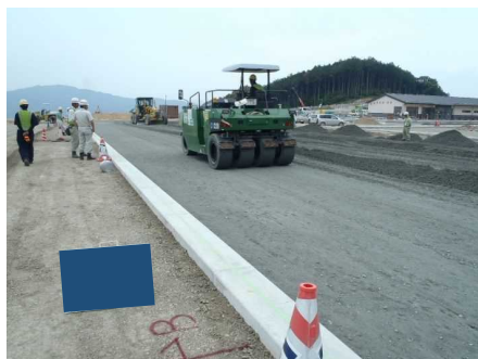
締固め(1次転圧)
