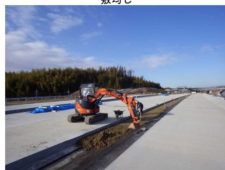
【中央分離帯部】 敷均し
