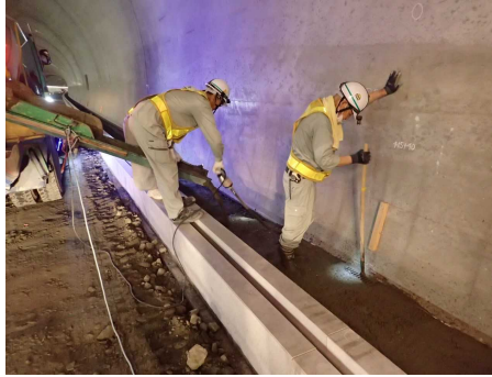
均しコンクリート打設
