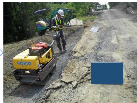
基礎材締固め
