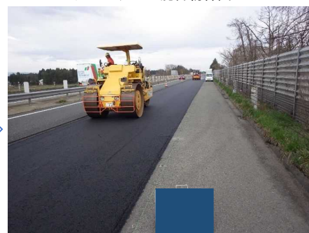
アスファルト混合物締固め
