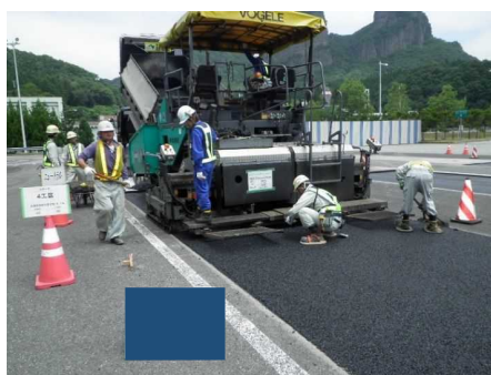
試験舗装(敷均し)
