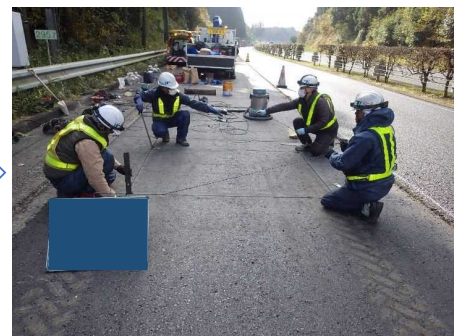
ループコイル埋設
