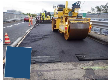
締固め（1次転圧）
