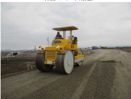
締固め（1次転圧）
