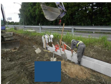
プレキャスト製品(U字溝)の据付
