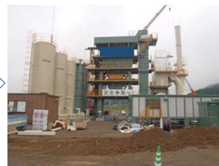
仮設完了(電気配線など)
