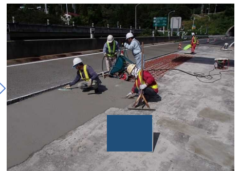
断面修復（コンクリート打設）
