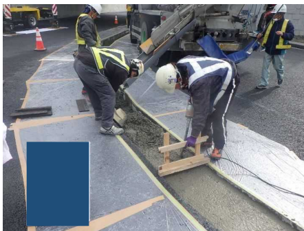
基礎コンクリート打設
