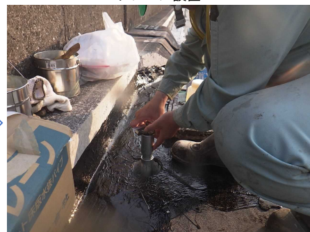
ドレーン設置
