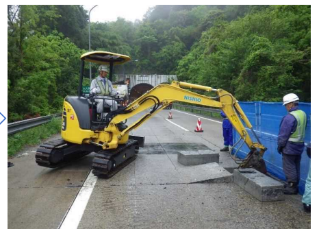
既設舗装の剥取り
