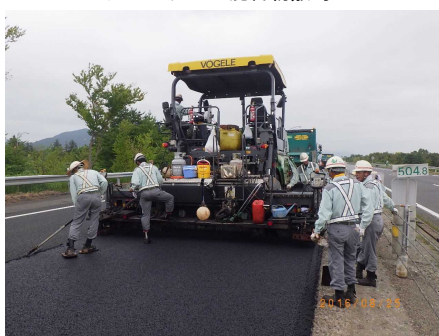
アスファルト混合物敷均し
