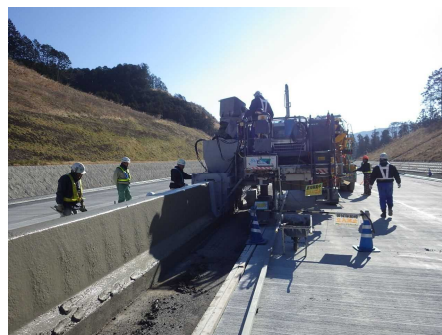
コンクリート打設
