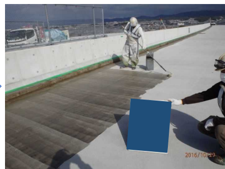
床版用接着材塗布
