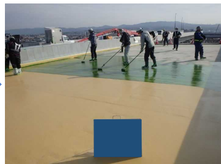
舗装用接着材塗布
