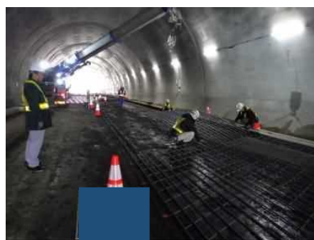
鉄筋設置状況
