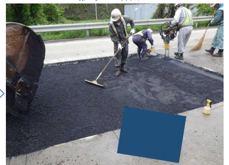
敷均し・締固め
