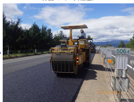
締固め（1次転圧）
