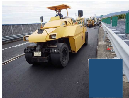
締固め（2次転圧）
