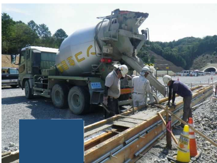
コンクリート打設
