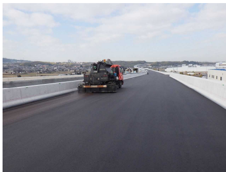
瀝青材散布工
