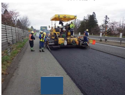
アスファルト混合物敷均し
