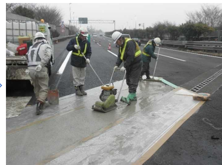
セメントミルクの振動・締固め
