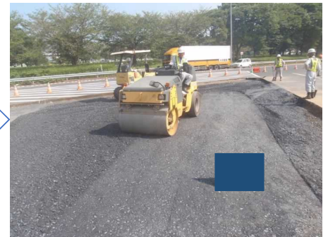
締固め(1次転圧)
