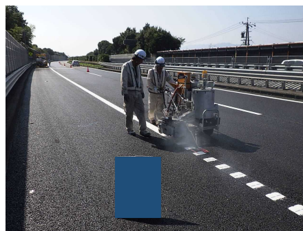
路面標示（ライン）施工
