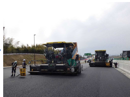
アスファルト混合物敷均し
