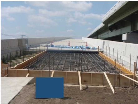
型枠設置・鉄筋工
