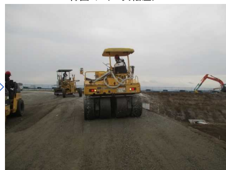
締固め（2次転圧）
