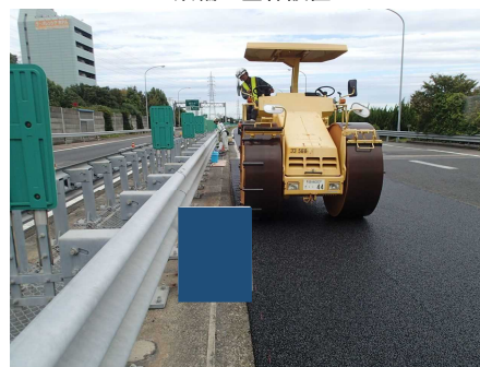
鉄輪に型枠設置
