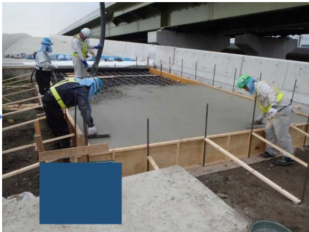
コンクリート打設
