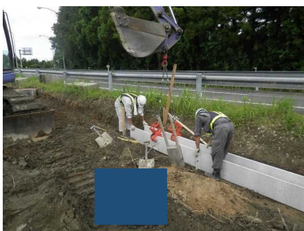
プレキャスト製品(U字溝)の据付
