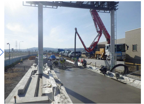
コンクリート打設
