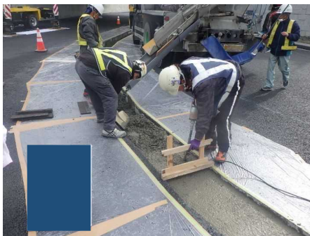
基礎コンクリート打設
