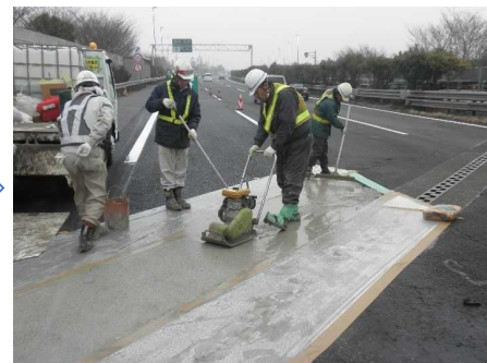
セメントミルクの振動・締固め
