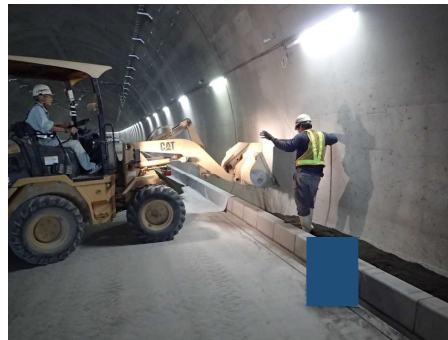
中詰土充填・締固め
