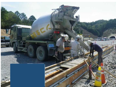
コンクリート打設
