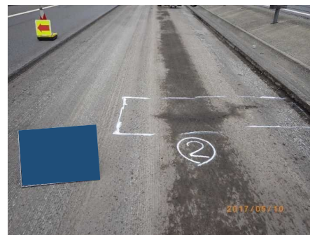
施工前（ひび割れ状況）
