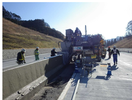
コンクリート打設
