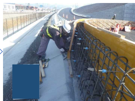
鉄筋工・型枠工
