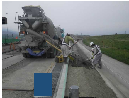
コンクリート打設
