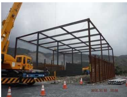
骨材仕切、上屋設置
