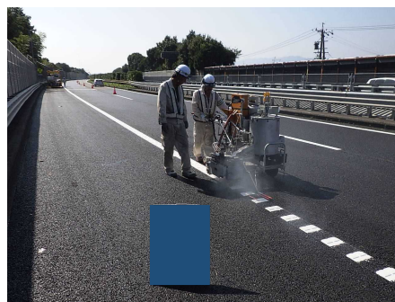
路面標示（ライン）施工
