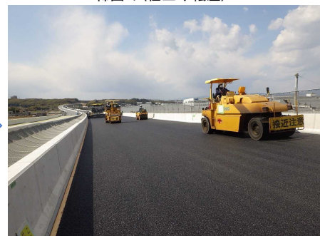
締固め(仕上げ転圧)
