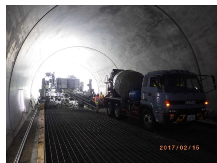
コンクリート打設
