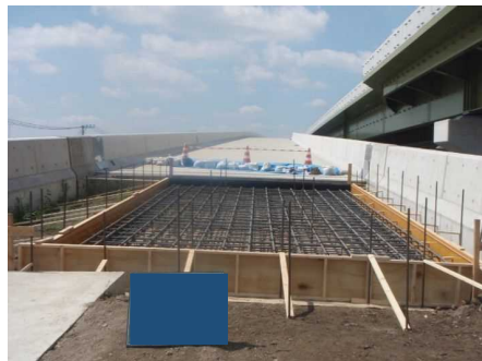
型枠設置・鉄筋工
