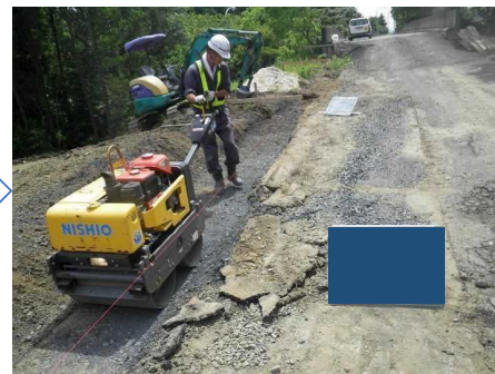
基礎材締固め
