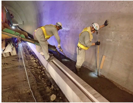
均しコンクリート打設
