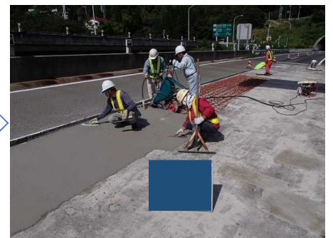
断面修復（コンクリート打設）
