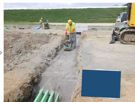
保護砂埋戻し・締固め
