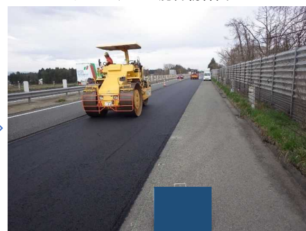
アスファルト混合物締固め
