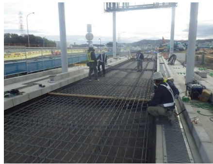
鉄網・補強鉄筋配置
