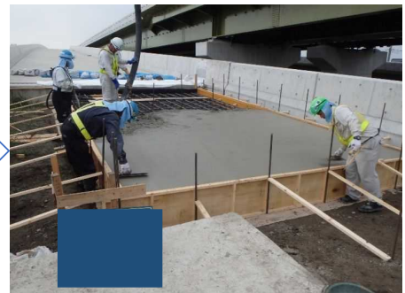
コンクリート打設
