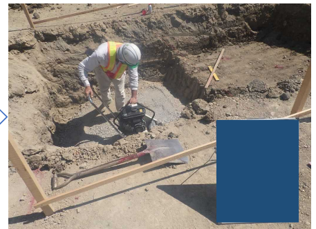
基礎材締固め
