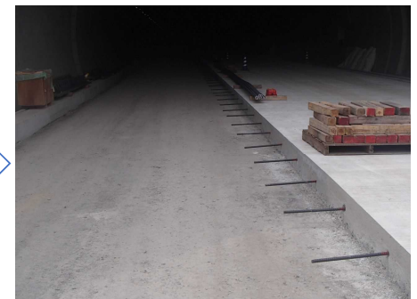
1車線分打設完了
