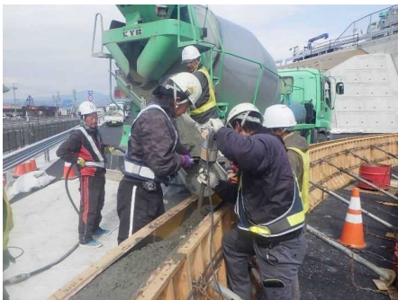
コンクリート打設
