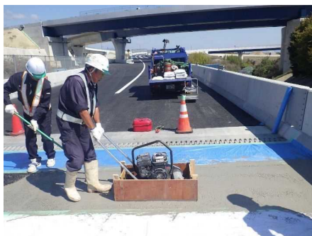
セメントミルク振動・締固め
