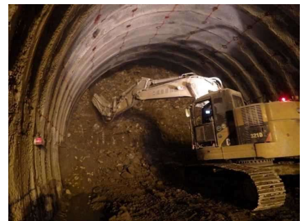
上半掘削（油圧切削機）
