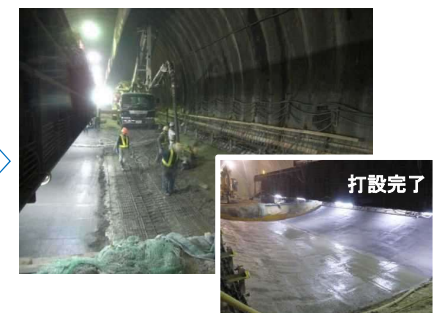
インバートコンクリート打設
