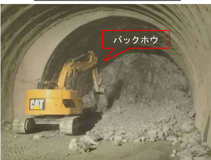
すり処理（すり積み）
