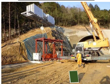
換気設備工（設置状況）
