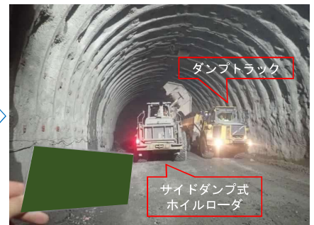
すり処理（すり積み・運搬）
