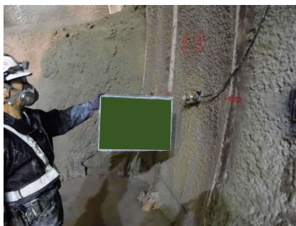
計測工B（ロックボルト軸力試験）
