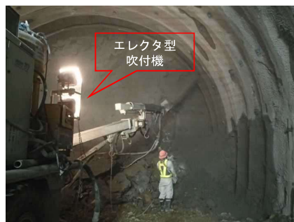
吹付コンクリート
