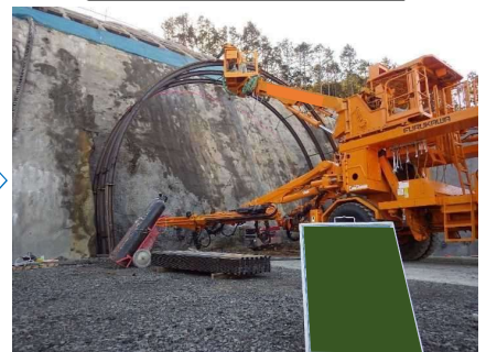
鋼アーチ支保工設置
