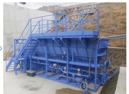
汚濁水処理工（設置完了）
