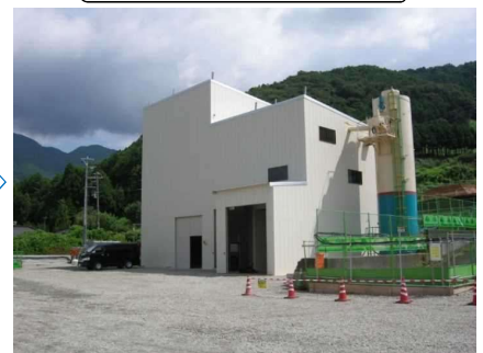
吹付設備工（設置完了）
