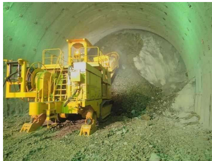
上半掘削（トンネル掘進機）
