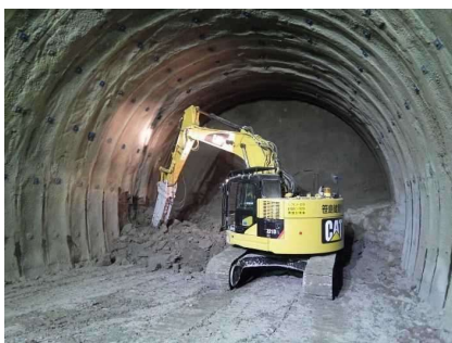
下半掘削（ブレーカ）
