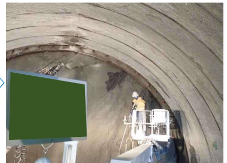
モルタル充填（フォアポーリング）
