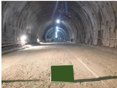
インバート締固め完了
