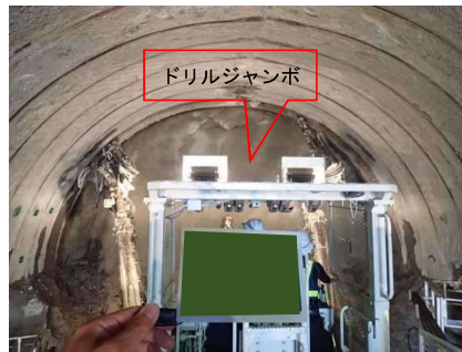
削孔（フォアポーリング）
