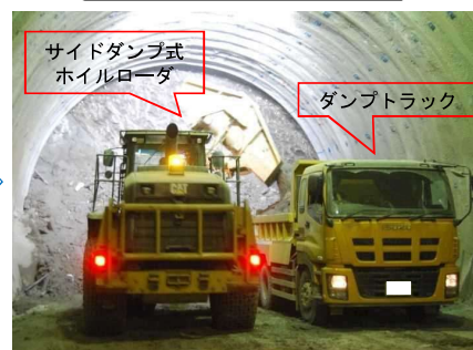
ずり処理（ずり積み込み）
