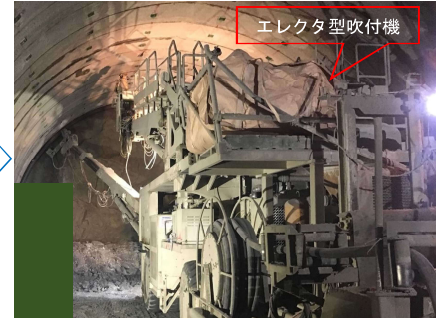
鋼アーチ支保工
