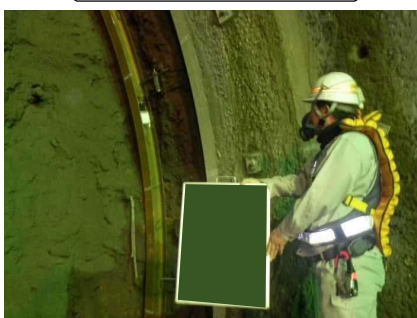
計測工B（覆工の応力測定）
