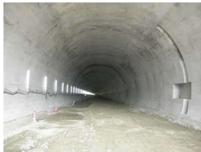
覆工コンクリート打設完了
