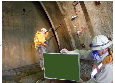
モルタル充填（ロックボルト）
