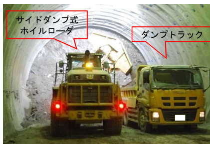
ずり処理（ずり積み）
