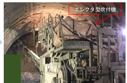
鋼アーチ支保工
