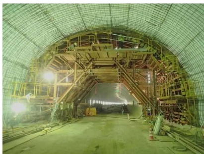
型わく据付完了
