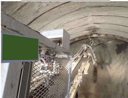
打設（フォアポーリング）
