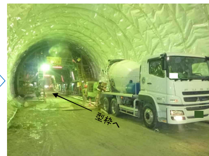
覆工コンクリート (ミキサー車)
