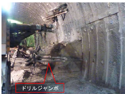
ロックボルト打設
