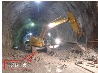
インバート掘削
