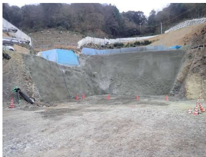
吹付コンクリート施工
