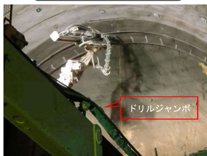
削孔（フォアポーリング）
