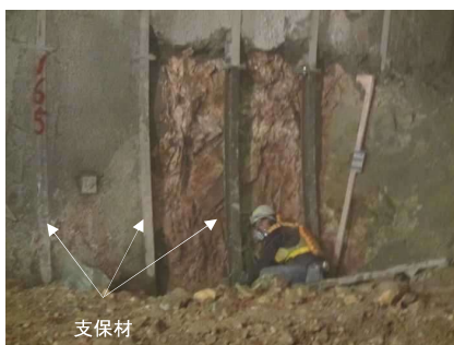
鋼アーチ支保工
