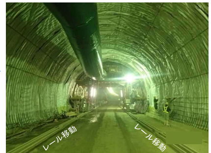
型枠移動（養生完了後）
