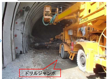
削孔（ロックボルト）
