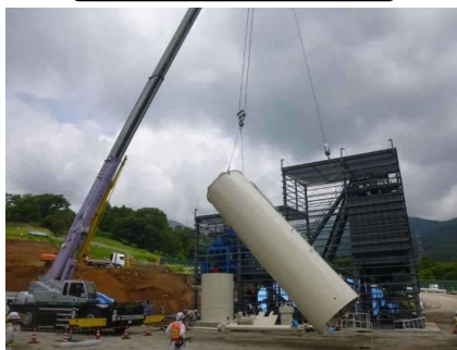
吹付設備工（搬入設置状況）
