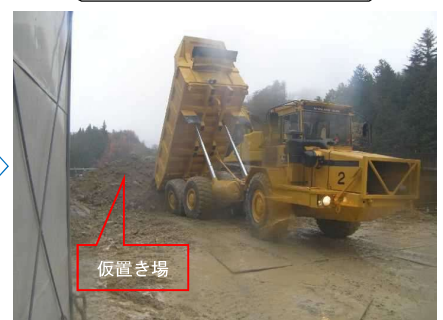
すり処理（すり荷卸し）
