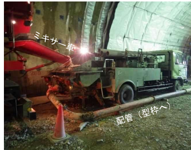
覆工コンクリート（打設）
