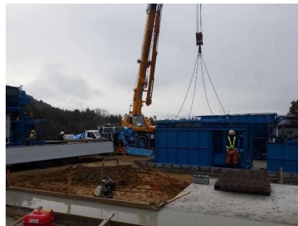
汚濁水処理工（設置状況）
