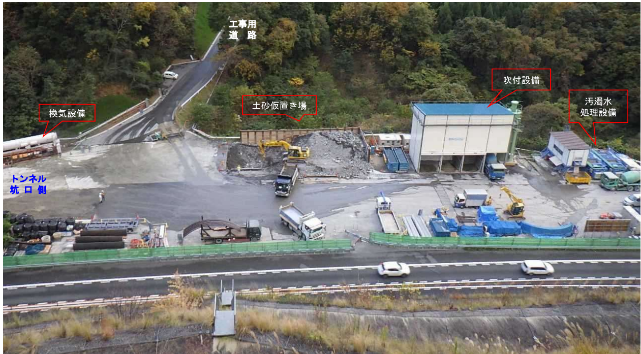
施工ヤード全景
