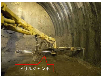
削孔（ロックボルト）
