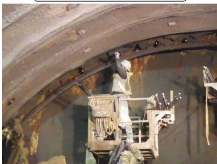
打設（フォアポーリング）
