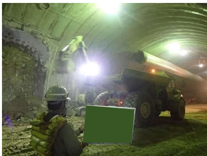
ずり処理（ずり積み込み）
