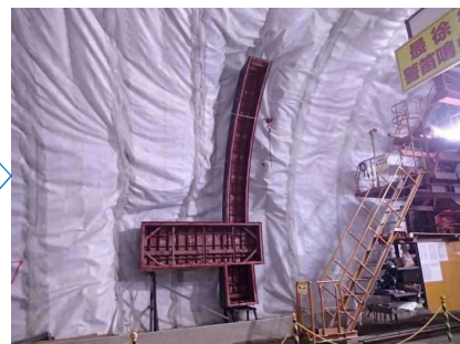
型わく据付 (箱抜き型わく)
