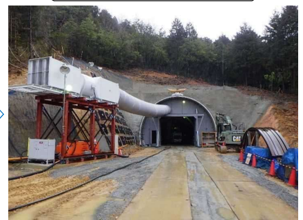
換気設備工（設置完了）
