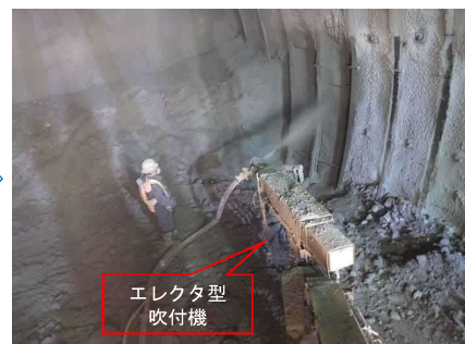
吹付コンクリート
