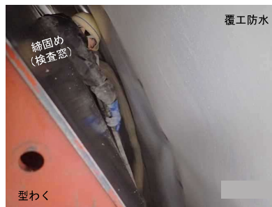
覆工コンクリート（打設）
