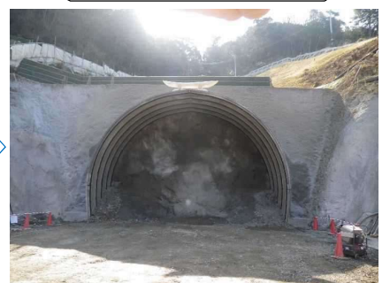
坑口切付け施工完了
