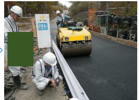
簡易舗装工 (締めめ)
