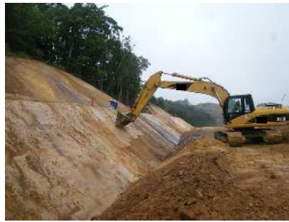
切土のり面仕上げ（土砂）
