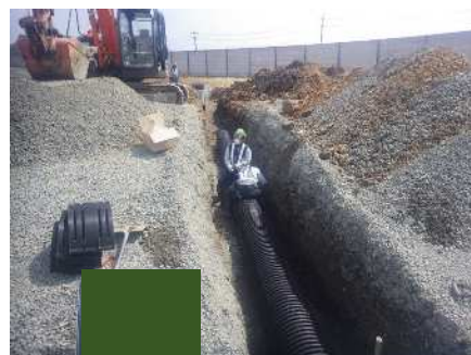
用排水管設置
