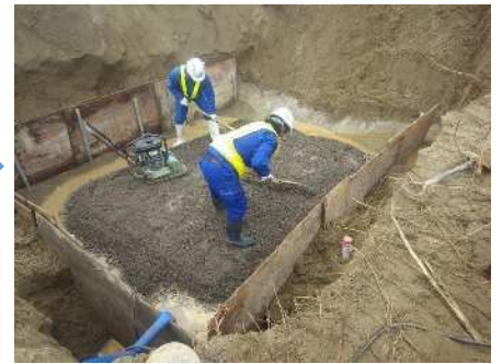
基礎材敷均し・締固め
