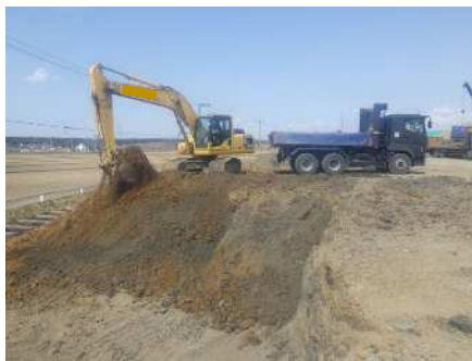
掘削・積み込み
