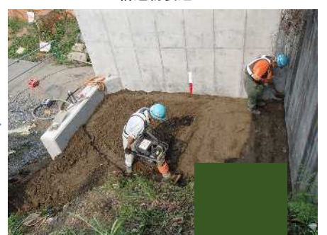
構造物裏込め
