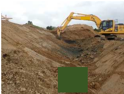
切土のり面仕上げ（土砂）
