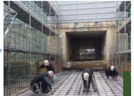
底版鉄筋加工・組立て
