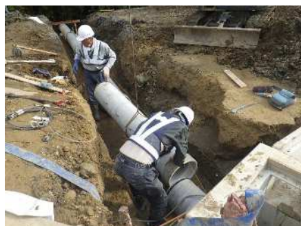
用排水管設置
