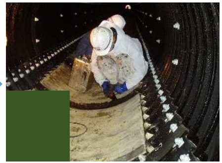
パイプ組立（目地仕上げ）
