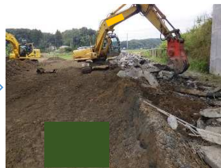
取壊し（圧碎機）
