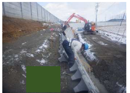
コンクリートブロック積み②
