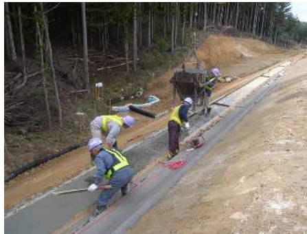
コンクリート打設
