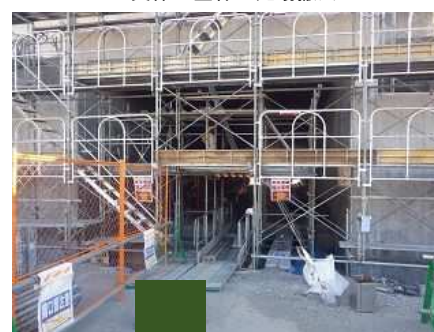
支保・型枠・足場撤去
