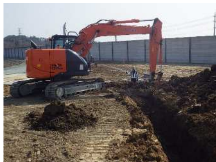
掘削・整正（床付）
