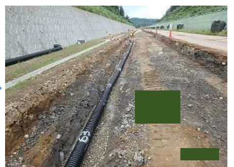
地下排水管設置
