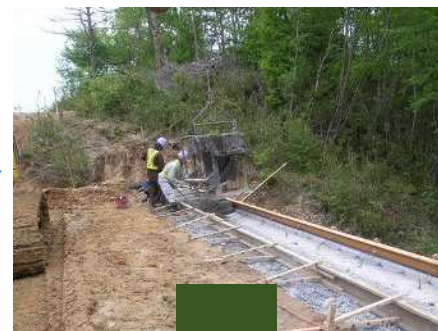
天端コンクリート打設
