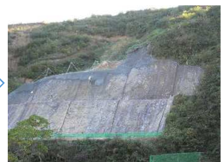
モルタル吹付
