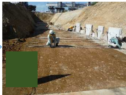
補強材設置
