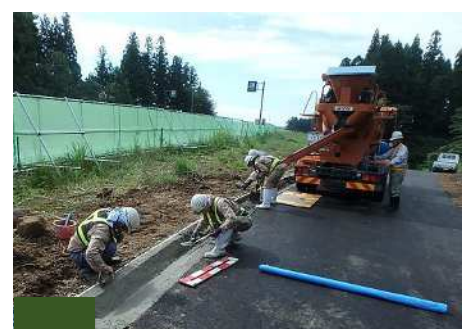
コンクリート打設
