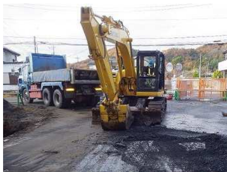
舗装版取壊し
