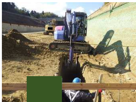
掘削・整正（床付）
