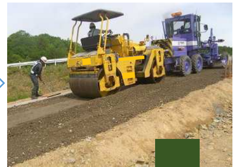
簡易舗装路盤工 (転圧)
