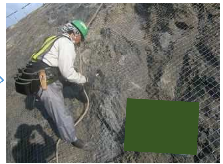
アンカーピン設置
