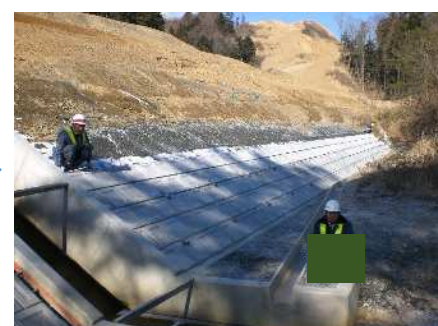
コンクリートブロック張り
