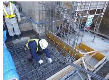
底板鉄筋加工・組立て
