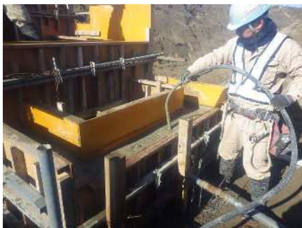
コンクリート打設
