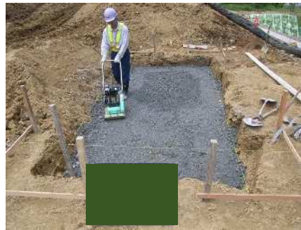
基礎材敷均し・締固め
