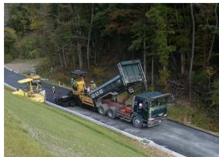
簡易舗装工（敷均し）
