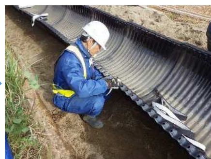
パイプ組立（ボトムセクション）
