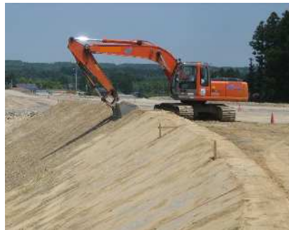
盛土のり面仕上げ（削取り）
