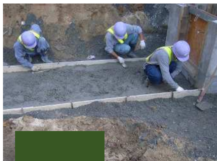
均しコンクリート打設
