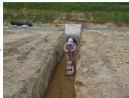
基礎材敷均し・締固め
