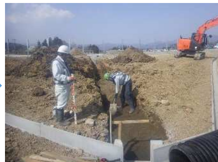
基礎材敷均し・締固め
