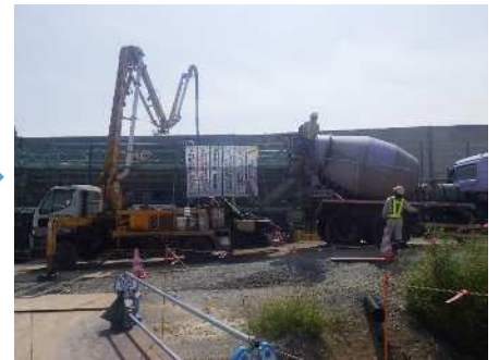
コンクリート打設・養生
