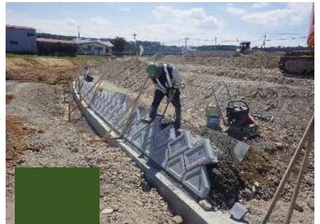
胴込め（コンクリート）
