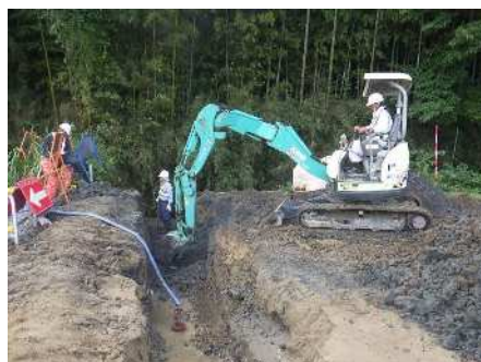
掘削・整正（床付）
