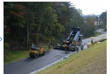
簡易舗装工（締固め）
