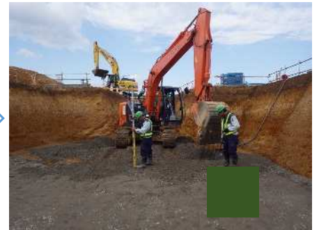
基礎材敷均し
