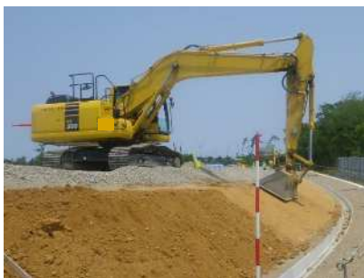
盛土のり面仕上げ（削取り）
