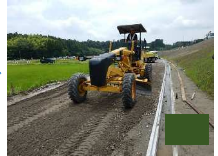
簡易舗装路盤工
