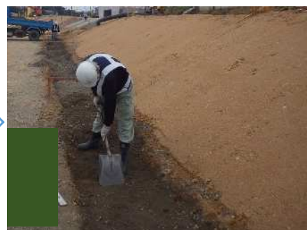
基礎材敷均し・締固め
