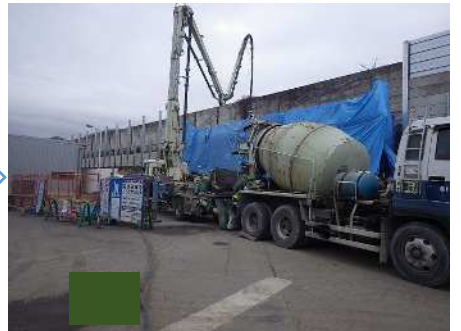
コンクリート打設・養生
