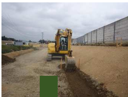
掘削・整正（床付）
