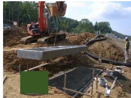
油水分離ます設置
