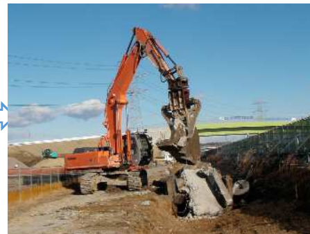
取壊し（圧碎機）
