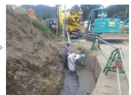
コンクリート打設
