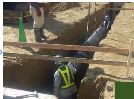
用排水管設置
