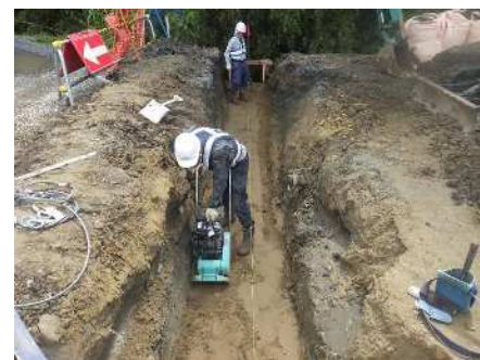
基礎材敷均し・締固め
