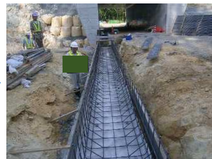
鉄筋加工・組立て
