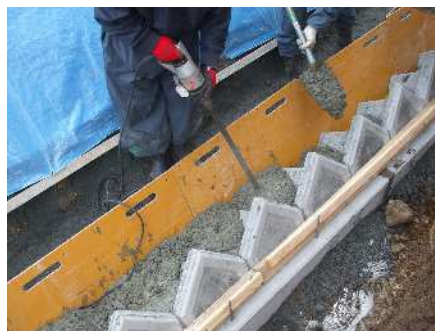
胴込め（※コンクリート打設の場合）
