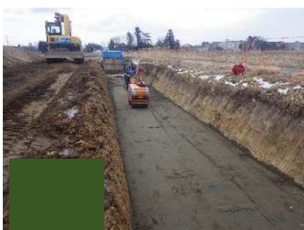
基礎材敷均し・締固め
