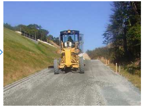
簡易舗装路盤工
