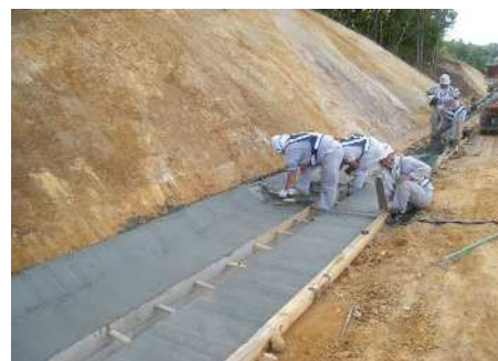
コンクリート打設
