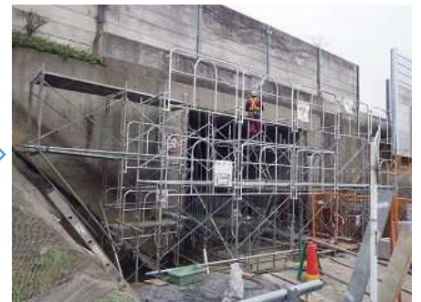
足場・支保設置
