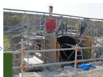
コンクリート打設②
