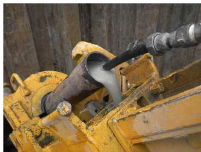
グラウト注入
