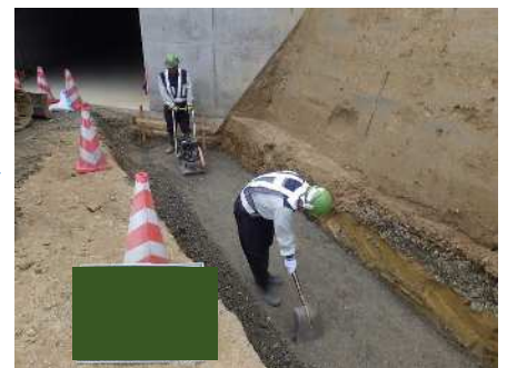
基礎材敷均し・締固め
