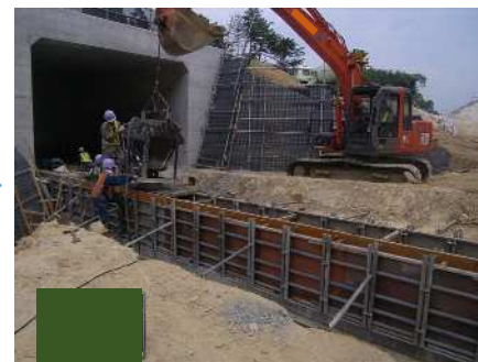
コンクリート打設
