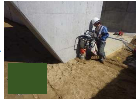
構造物裏込め
