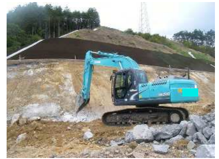
切土のり面仕上げ（硬岩）
