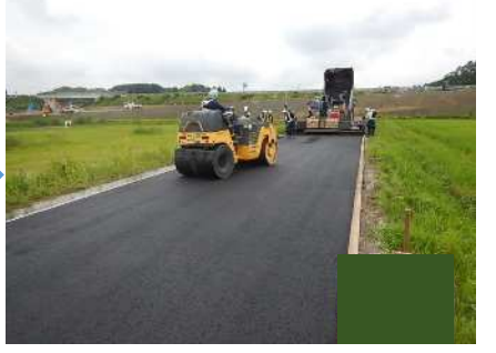
簡易舗装工（締固め）
