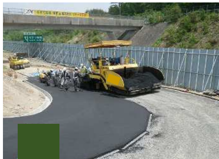
簡易舗装工 (敷均し)
