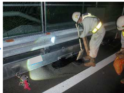
仮設防護柵据付
