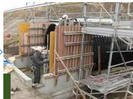
型枠組立②
