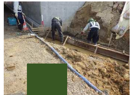
コンクリート打設
