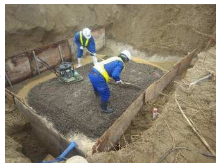
基礎材敷均し・締固め
