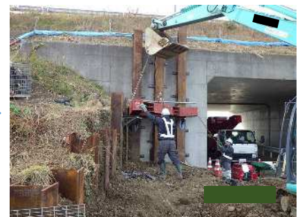
鋼製山留材設置
