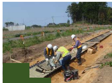
パイプ組立（ボトムセクション）
