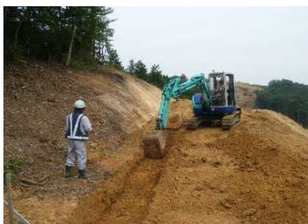
掘削・整正（床付）
