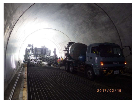
コンクリート打設
