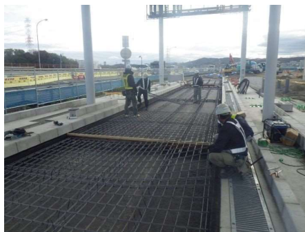
鉄網・補強鉄筋配置
