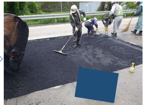
敷均し・締固め
