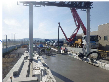
コンクリート打設
