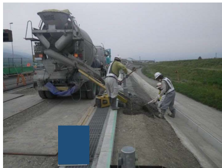
コンクリート打設
