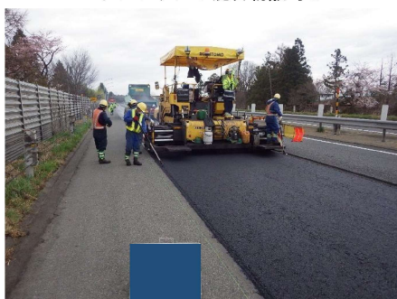
アスファルト混合物敷均し
