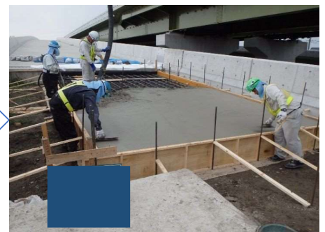
コンクリート打設
