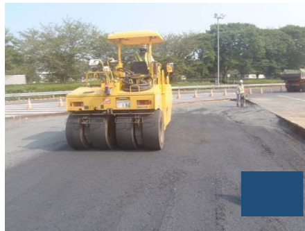
締固め(2次転圧)
