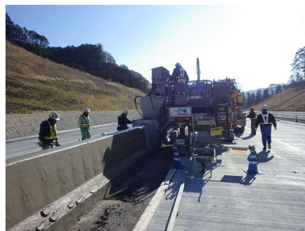
コンクリート打設
