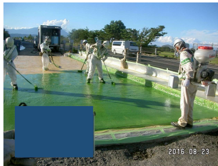
舗装接着材塗布
