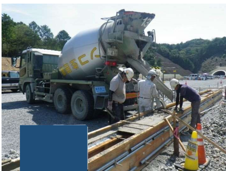
コンクリート打設
