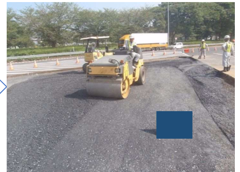
締固め(1次転圧)
