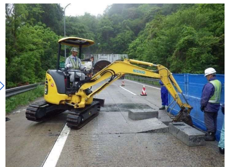
既設舗装の剥取り
