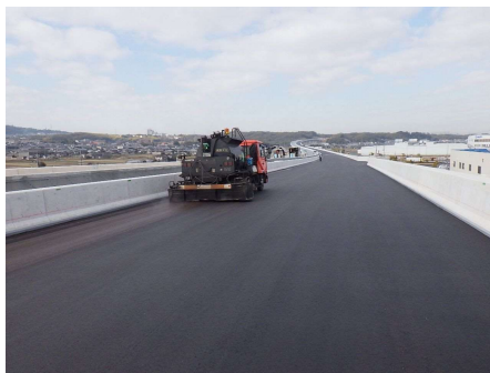
瀝青材散布工
