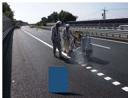
路面標示（ライン）施工
