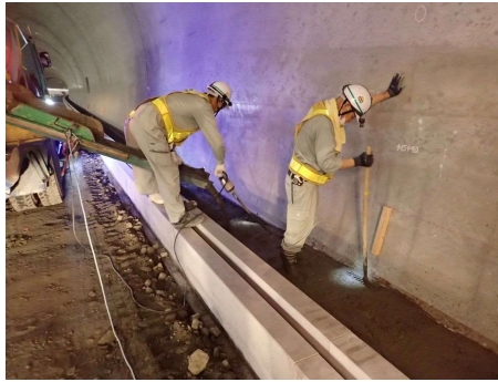
均しコンクリート打設
