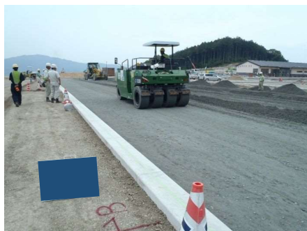
締固め(1次転圧)
