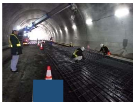
鉄筋設置状況
