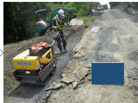
基礎材締固め
