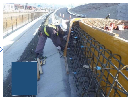
鉄筋工・型枠工
