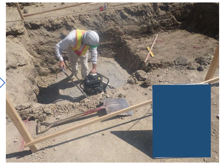
基礎材締固め
