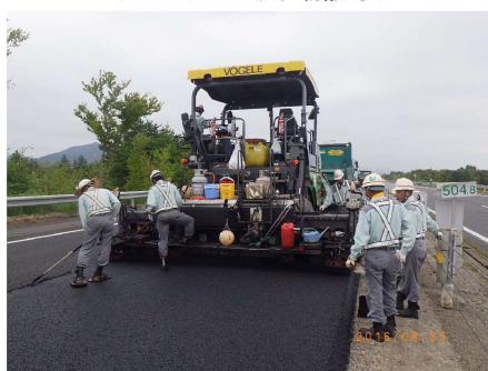
アスファルト混合物敷均し
