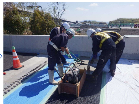
セメントミルク注入
