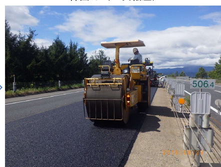
締固め（1次転圧）
