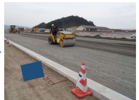
締固め(2次転圧)
