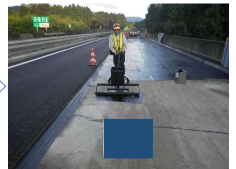
プライマー塗布
