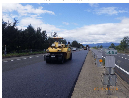
締固め（2次転圧）
