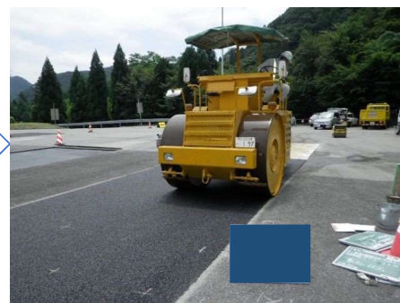
試験舗装(1次転圧)
