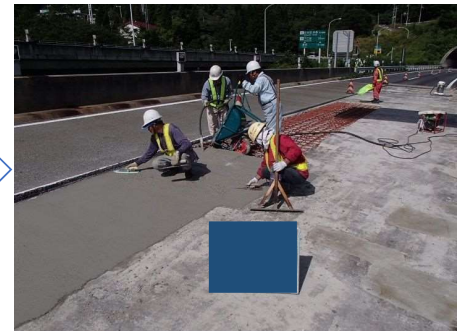
断面修復（コンクリート打設）
