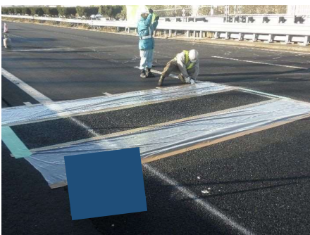
マスキング設置
