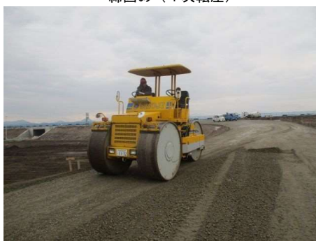
締固め（1次転圧）
