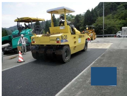
試験舗装(2次転圧)
