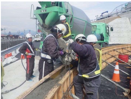
コンクリート打設
