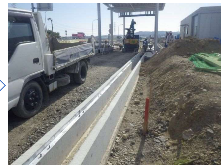
用排水溝完成
