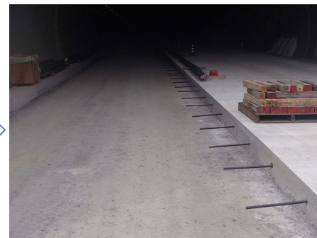
1車線分打設完了
