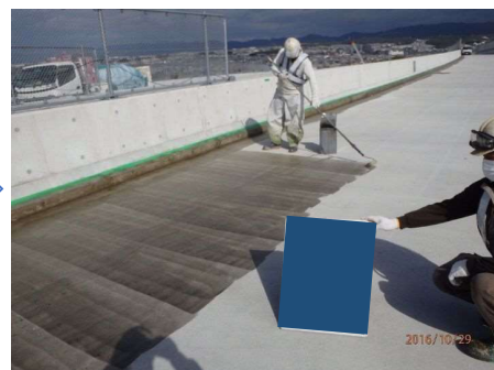
床版用接着材塗布
