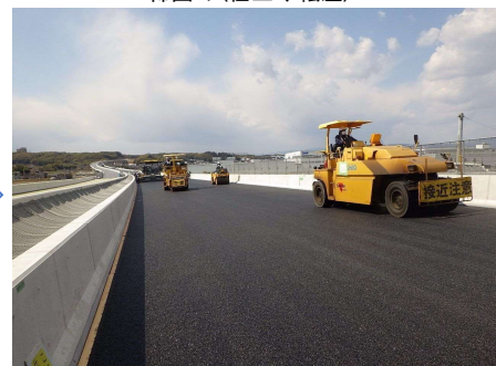
締固め(仕上げ転圧)
