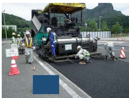
試験舗装(敷均し)
