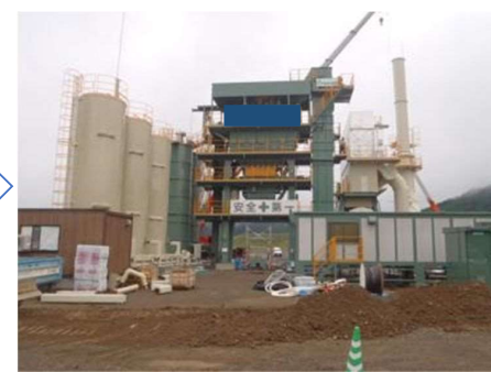
仮設完了(電気配線など)
