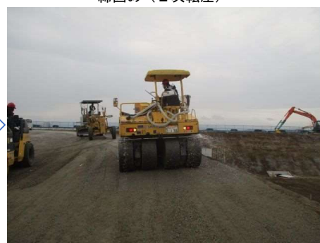
締固め（2次転圧）
