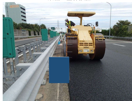
鉄輪に型枠設置
