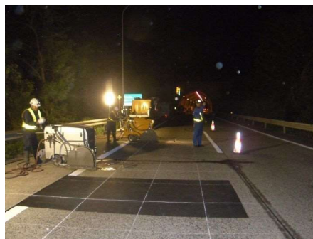
既設舗装の切断
