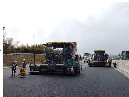
アスファルト混合物敷均し
