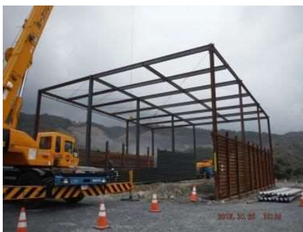
骨材仕切、上屋設置
