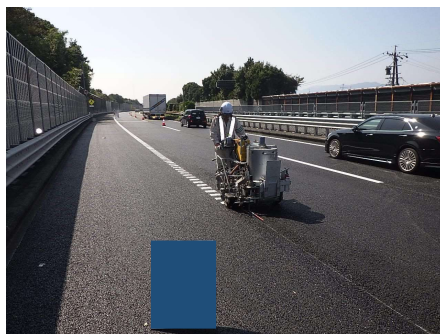
リブのみ施工
