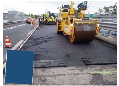
締固め（1次転圧）
