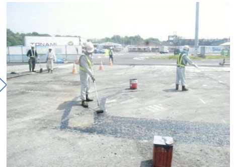
瀝青材散布工
