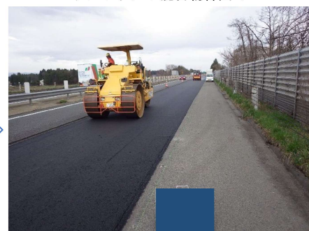
アスファルト混合物締固め
