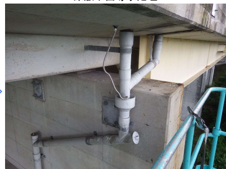
床版下面導水処理
