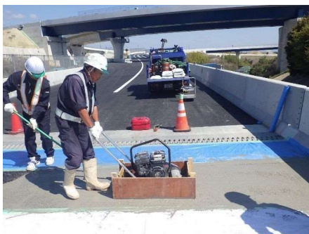
セメントミルク振動・締固め
