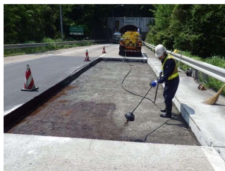
瀝青材散布工
