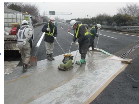
セメントミルクの振動・締固め
