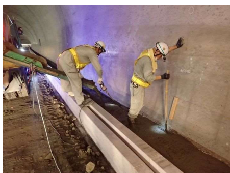
均しコンクリート打設
