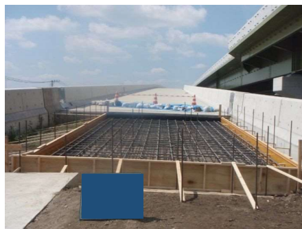
型枠設置・鉄筋工
