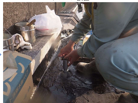
ドレーン設置
