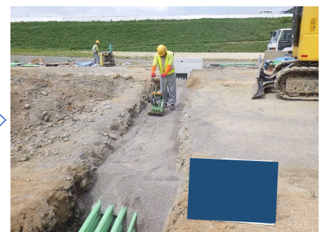
保護砂埋戻し・締固め
