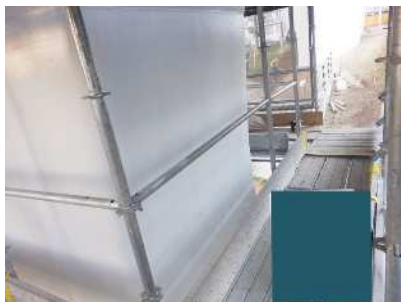
下塗り塗布完了
