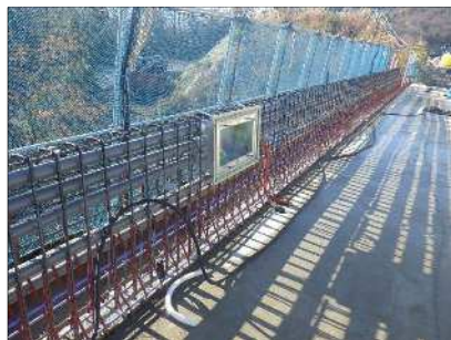
落橋防止構造 橋台側
