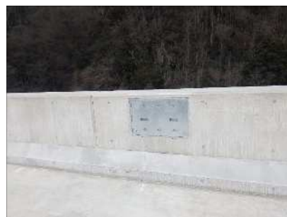
落橋防止構造 桁側
