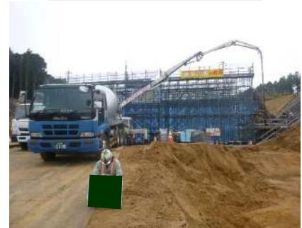
コンクリート打設
