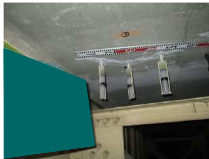
ひび割れ注入
