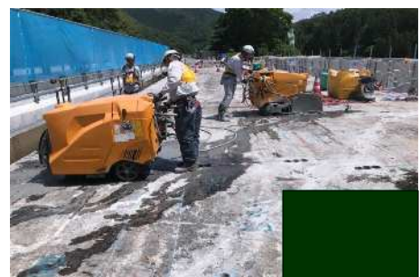
床版切断状況
