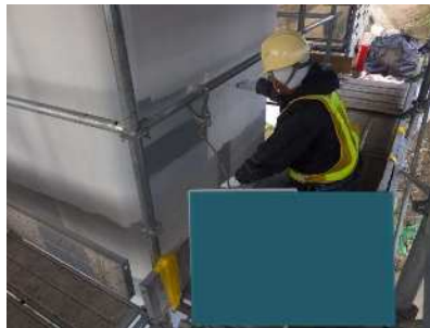
下塗り塗布状況
