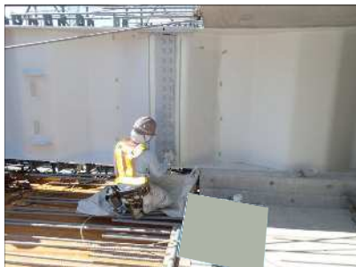
下床版コンクリート打設
