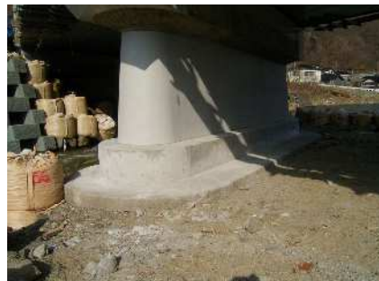
コンクリート打設完了
