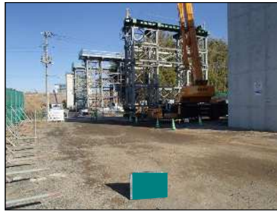
ベント設備組立
