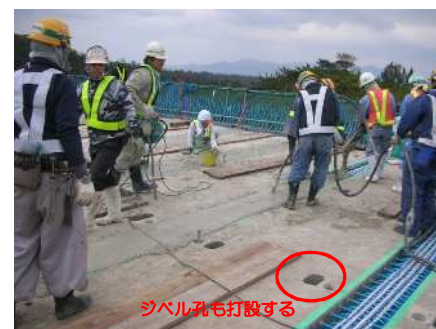
接合部コンクリート打設
