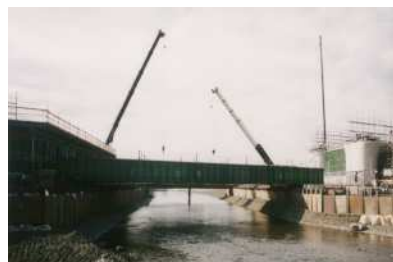
梁(架設桁)架設状況
