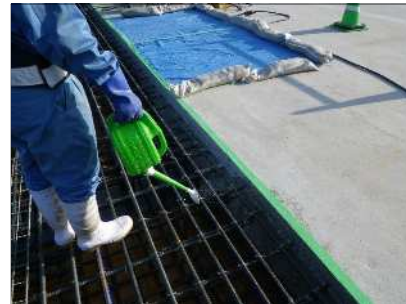
上床版コンクリート打設
