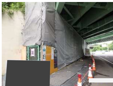
足場設置（外観）
