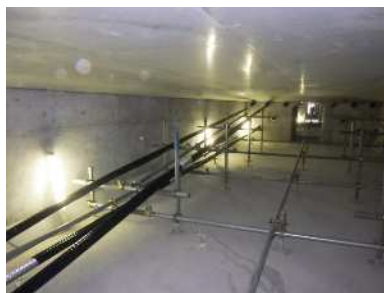
外ケーブル組立状況
