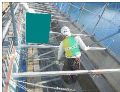
張 出 部 支 保 工
