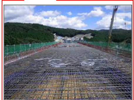
鉄筋組立完了
