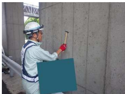
目視、打音検査
