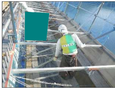
張出部支保工
