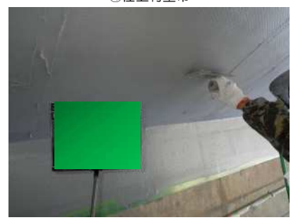
④仕上材塗布
