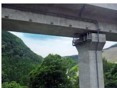
排水管（桁外）
