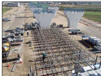
くさび結合式支保工施工例
