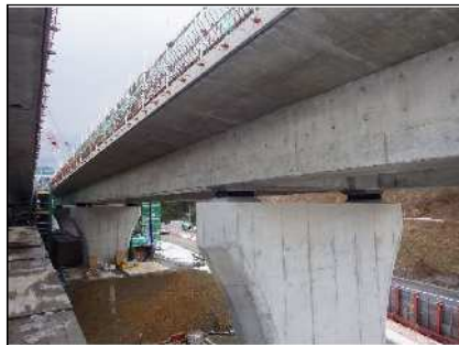
支保工撤去完了(参考例)
