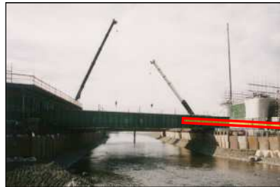
梁(架設桁)架設状況
