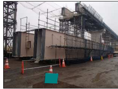
地組立（ボルト接合）
