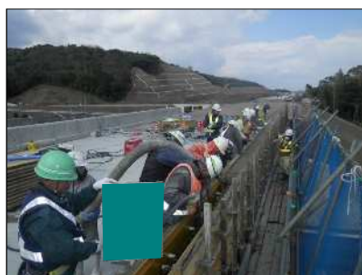
コンクリート打設
