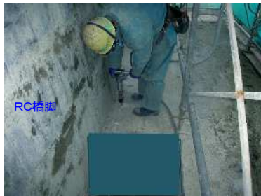
取付アンカー削孔状況
