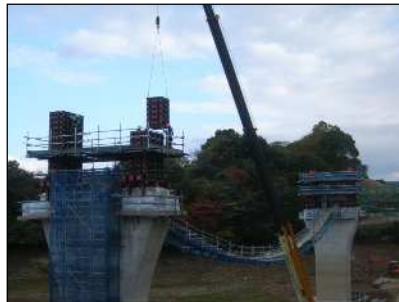
降下設備組立
