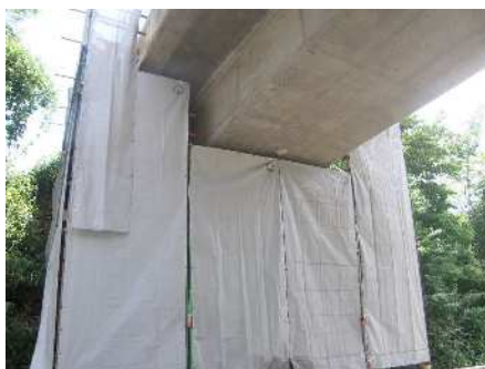
シート防護設置
