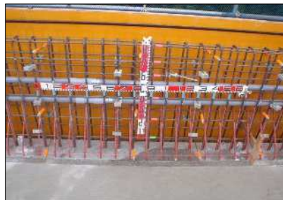
壁高欄コンクリート打設
