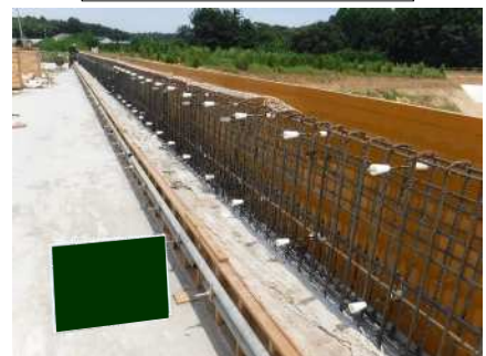
コンクリート打設(壁高欄)
