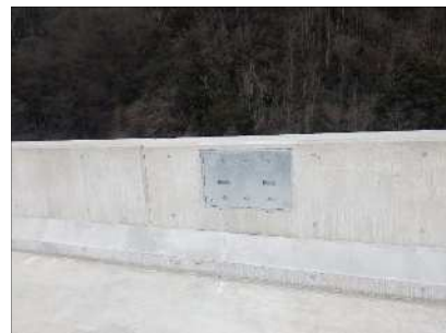
落橋防止構造 桁側
