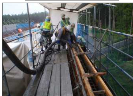
壁高欄コンクリート打設
