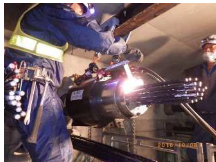
外ケーブル施工完了
