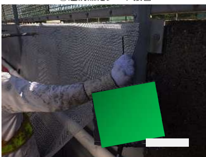
②連続繊維シート接着
