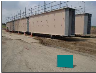
地組立（ボルト接合）
