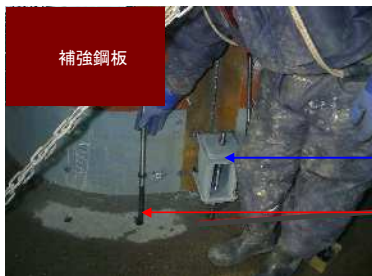
アンカーボルト取付状況
