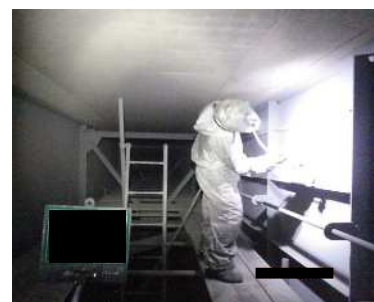
塗膜剥離剤塗布
