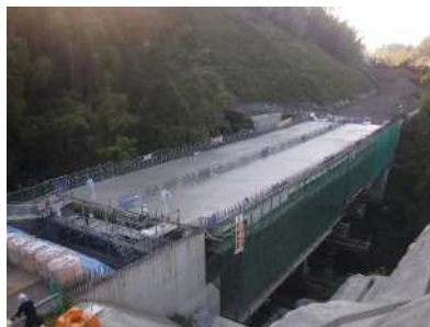
コンクリート打設完了
