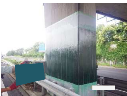
含浸接着樹脂塗布完了
