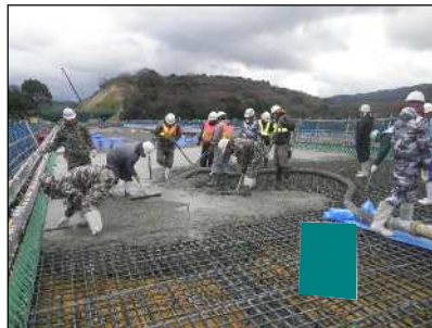
コンクリート打設
