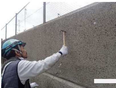
目視、打音検査
