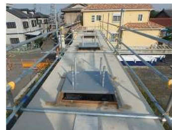
ゴム支承据付状況
