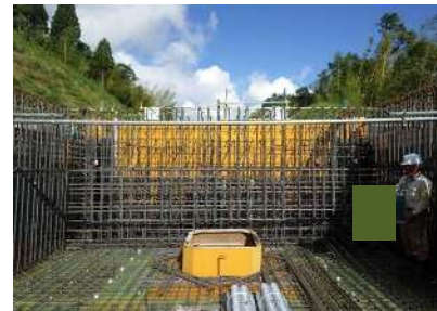
鉄筋・縦締め組立完了
