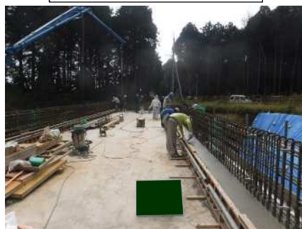
コンクリート打設(地覆)
