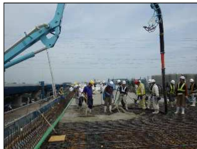
コンクリート打設
