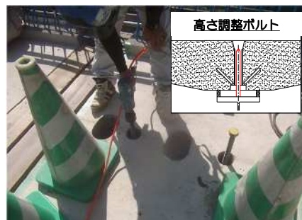
調整工（高さ調整ボルトによる）
