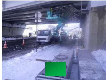
システム足場撤去
