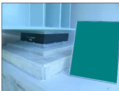
モ ル タ ル 打 設 完 了
