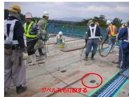
接合部コンクリート打設
