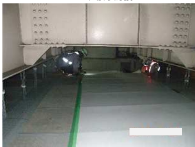
シート張り防護
