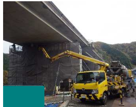
コンクリート打設
