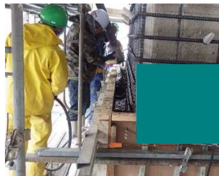
コンクリート打設
