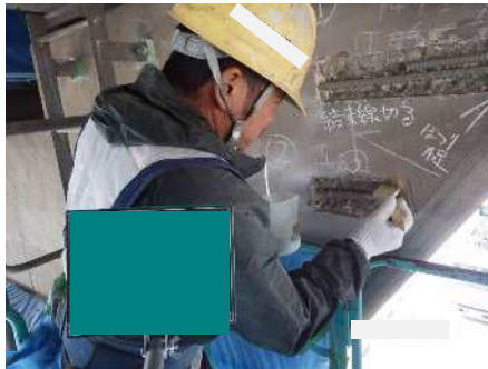
プライマー塗布
