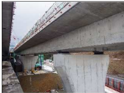
型枠支保工撤去完了
