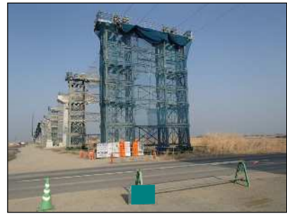
ベント設備組立完了
