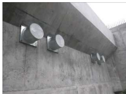
落橋防止構造 橋台側
