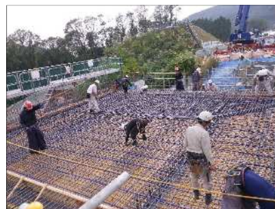
上床版コンクリート打設
