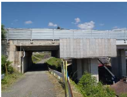
システム足場組立
