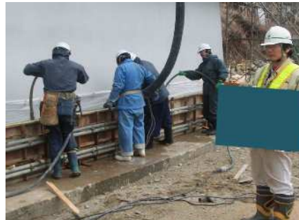
コンクリート打設状況
