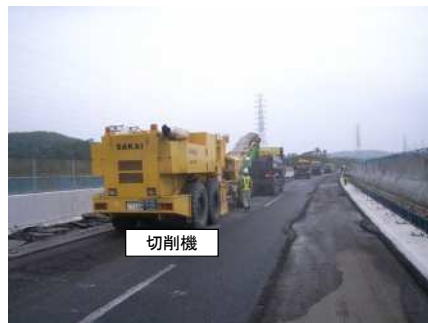
橋面舗装撤去
