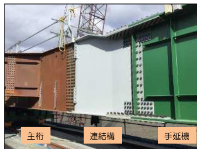
手延機・連結構
