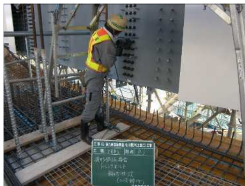
溶接継手施工例
