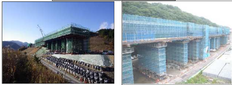
支柱式支保工施工例 (H 鋼梁)
