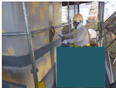
溶接部 下塗り状況
