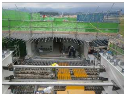
波形鋼板架設
