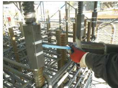
鉄筋継ぎ手
