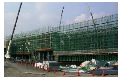
梁(架設桁)+くさび結合式支保工
