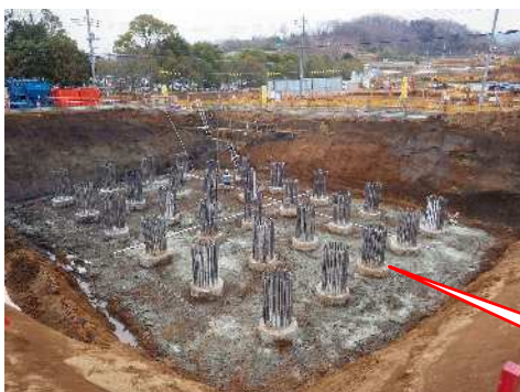
場所打ち杭 (杭頭処理後)
