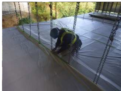
シート張り防護
