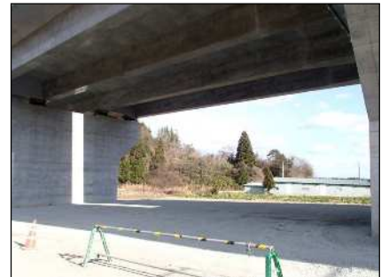
型枠支保工撤去完了
