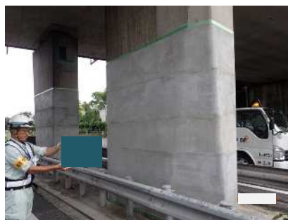
保護塗装（下塗り）完了
