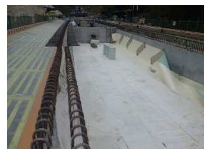
内型枠脱枠
