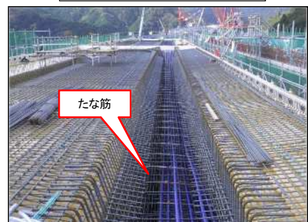
縦締めケーブル配置完了
