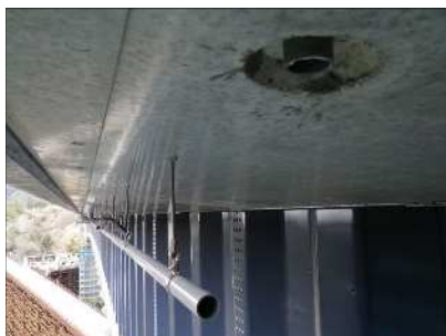
排水管（桁外）
