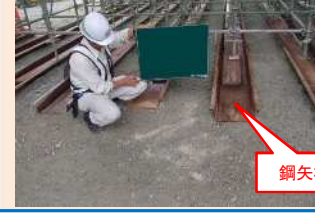
くさび結合式支保工の施工例
