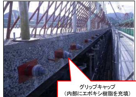
横 締 め 後 処 理 完 了
