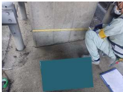
躯体寸法確認
