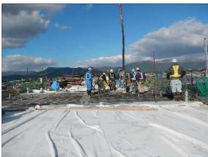
上床版コンクリート打設
