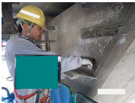
断面修復材塗布
