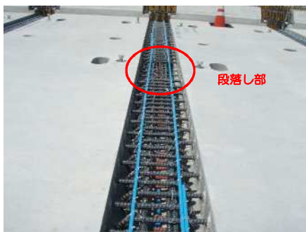
接合部コンクリート打設
