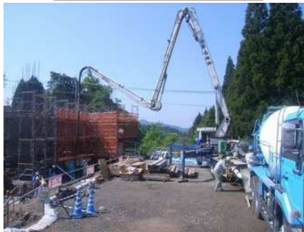
コンクリート工
