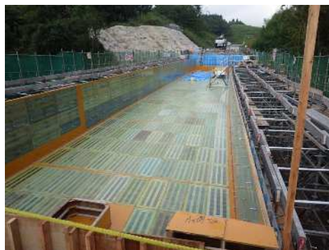
底板・側型枠組立
