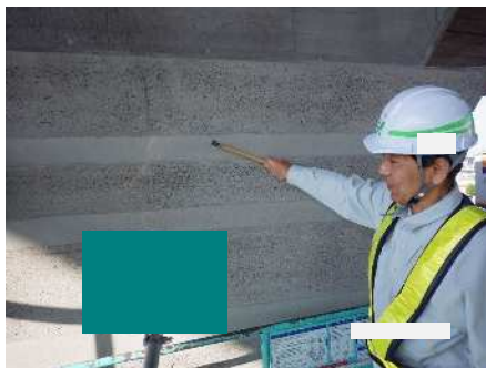
目視、打音検査
