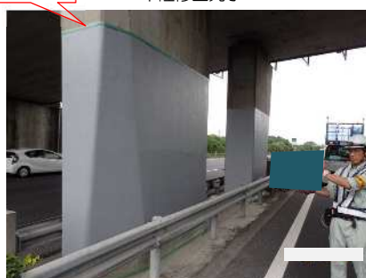
不陸修正完了
