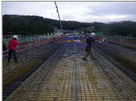
床版横締めケーブル配置状況
