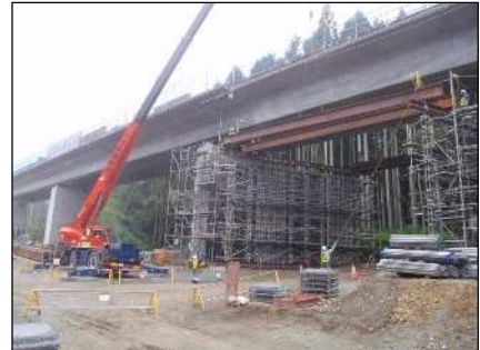
支保工撤去状況(参考例)
