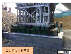
コンクリート基礎
