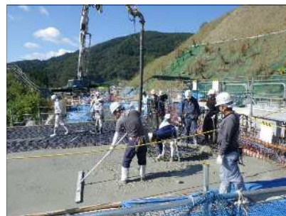
上床版コンクリート打設
