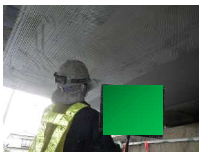
②連続繊維シート接着
