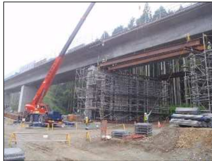
型枠支保工撤去完了
