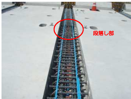
接合部コンクリート打設
