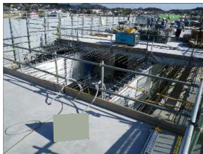
波形鋼板架設
