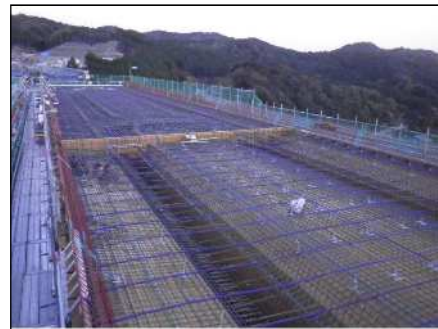
床版横締めケーブル配置完了
