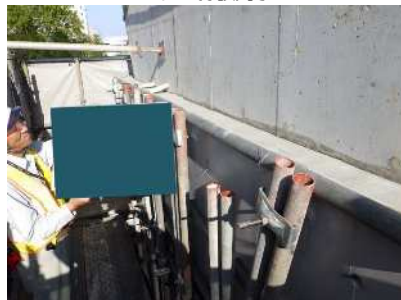
モルタル打設完了
