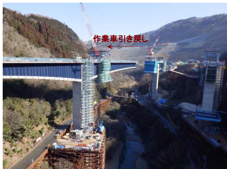
移動作業車後退・解体
