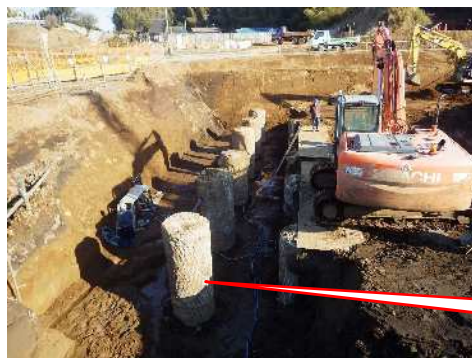
場所打ち杭 (杭頭処理前)
