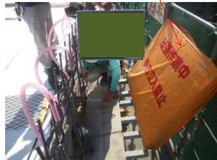
緊張状況（固定側）
