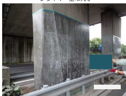
プライマー塗布完了
