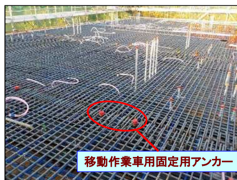
型枠・鉄筋・PC組立
