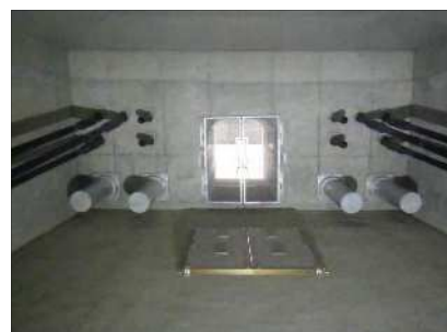
落橋防止構造 桁側
