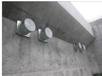
落橋防止構造 橋台側
