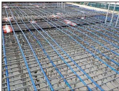
床版横締め組立
