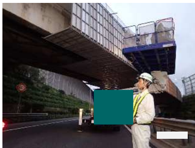
システム足場組立
