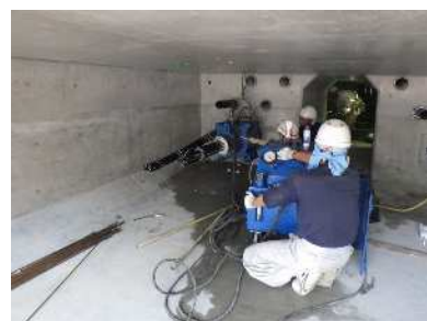
外ケーブル緊張状況
