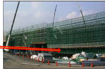
梁(架設桁)+くさび結合式支保工
