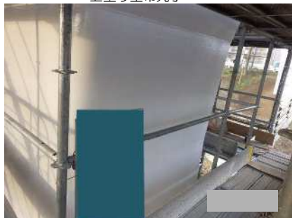
上塗り塗布完了
