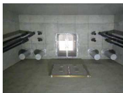
落橋防止構造 桁側
