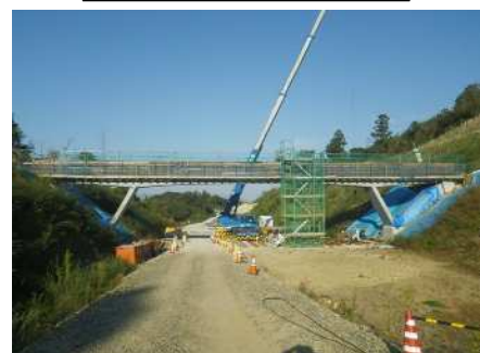
支保工撤去完了
