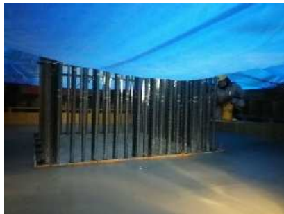
保温養生と遅延剤塗布
