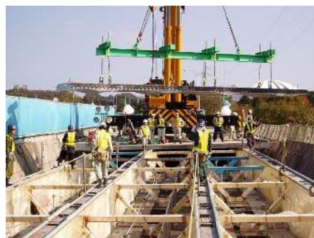
調整工（高さ調整ボルトによる）
