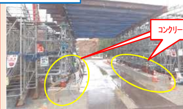
支柱式支保工の施工例
