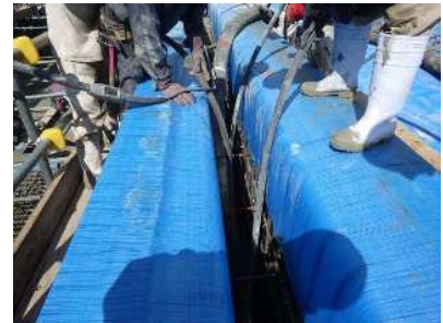
下床版コンクリート打設
