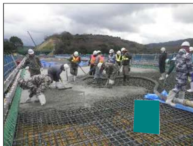
コンクリート打設
