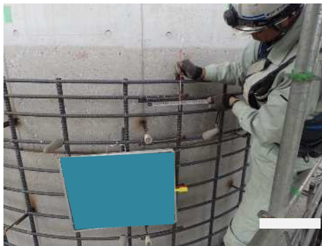
フレア溶接 外観形状寸法確認
