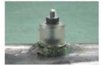
【樹脂注入前のフロート】
