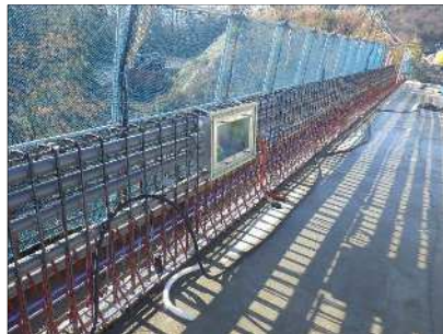
落橋防止構造 橋台側
