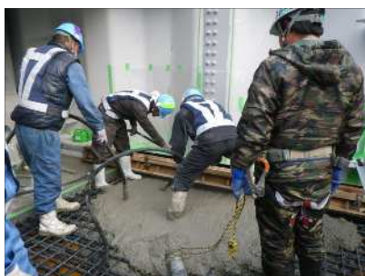
下床版コンクリート打設
