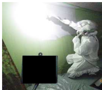
塗膜剥離剤塗布
