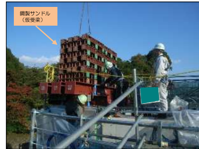
降下設備組立
