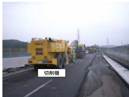
橋面舗装撤去
