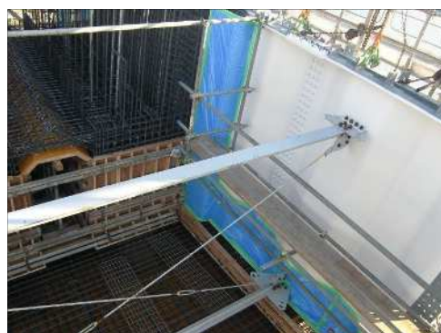
波形鋼板養生
