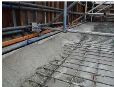
ウェブ下ハンチ部コンクリート充填
