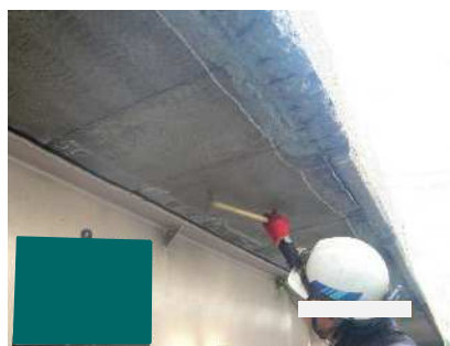
変状部分の確認・除去
