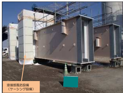
地組立（溶接接合）
