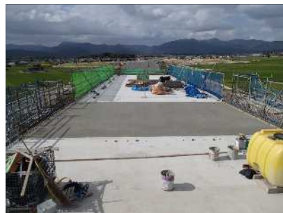
上床版コンクリート打設
