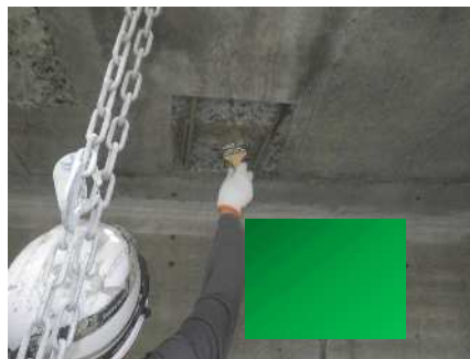
鉄筋防錆処理
