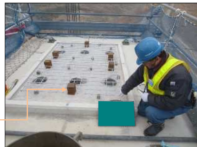
沓座鉄筋設置
