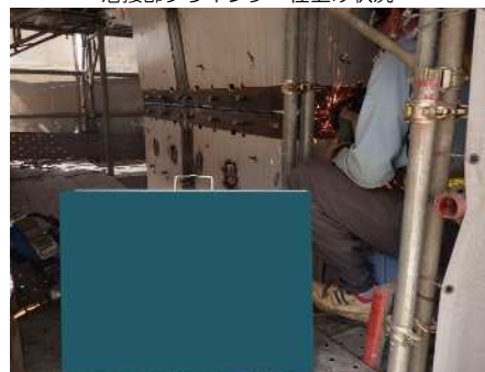
溶接部グラインダー仕上げ状況
