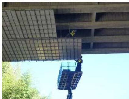
システム足場組立
