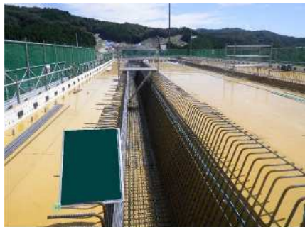
鉄筋組立作業状況
