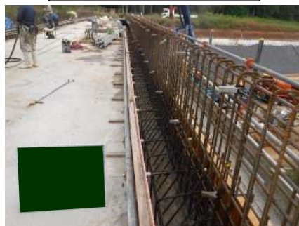
コンクリート打設(地覆)
