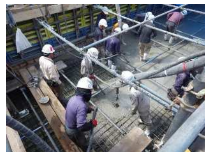
下床版コンクリート打設
