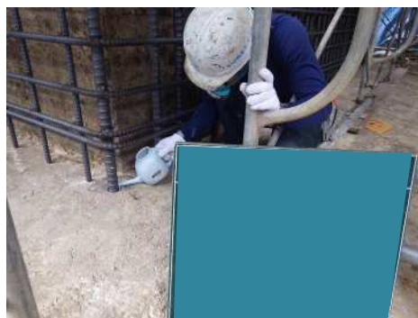
アンカー鉄筋樹脂定着
