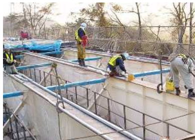
フランジシール工
