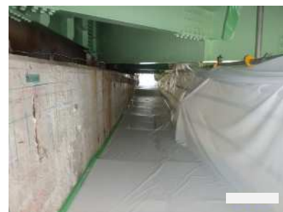
足場設置（内観）
