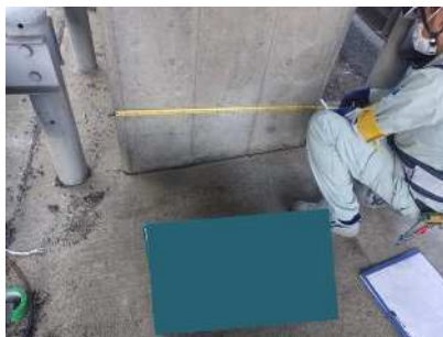
躯体寸法確認
