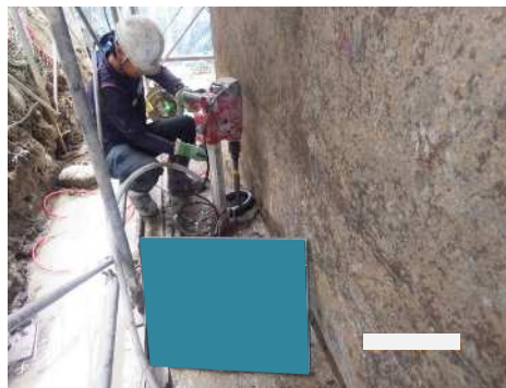
アンカー鉄筋樹脂定着
