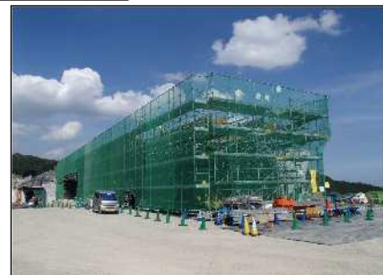
くさび結合式支保工施工例
