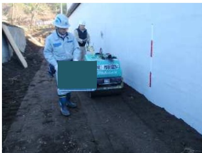
構造物掘削（掘削後転圧）
