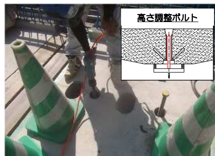
調整工（高さ調整ボルトによる）
