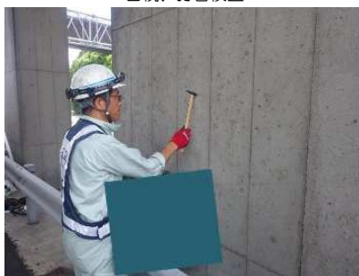
目視、打音検査
