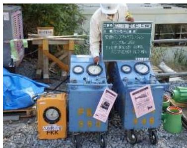
緊張ポンプキャリブレーション
