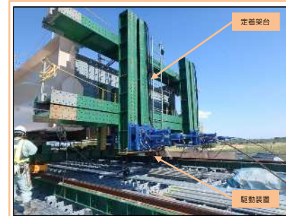
駆動装置・定着装置
