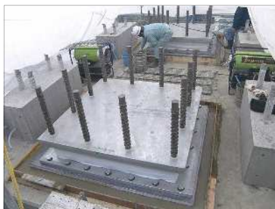
無収縮モルタル打設
