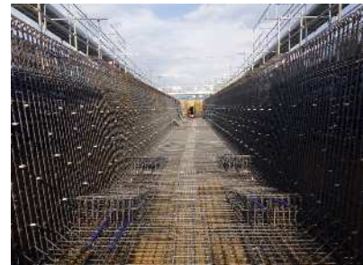
鉄筋・縦締め組立完了
