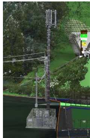
通信アンテナ塔
